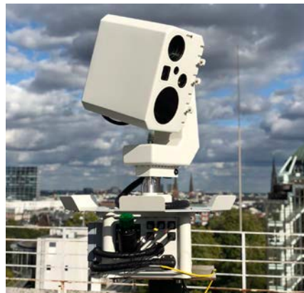
Abb. 4: MODAR-System, hier auf dem Dach des BSH in Hamburg installiert
