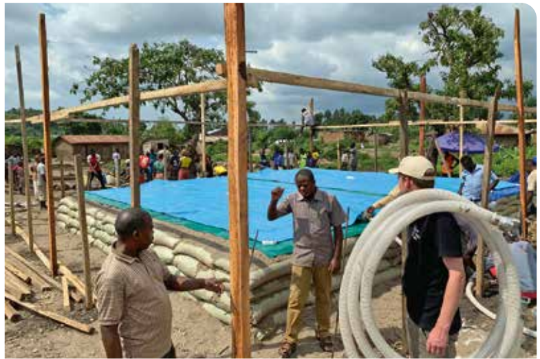
Innerhalb weniger Stunden ist die Wasseraufbereitungsanlage für knapp 3.000 Menschen aufgebaut.
