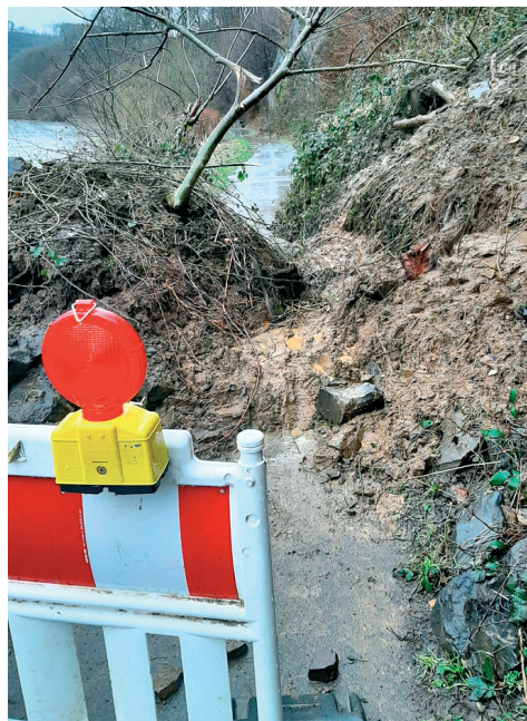
Hangrutsch in Dreisel: Der Siegradweg ist unterbrochen.
