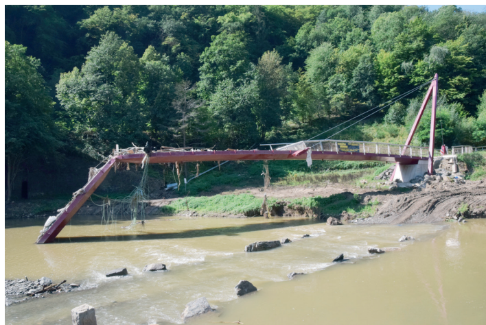
Die zerstörte Schrägseilbrücke für Radfahrer zwischen Mayschoß und Altenahr
