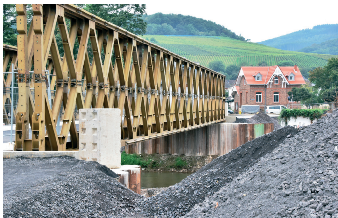
Provisorische Brücke über die Ahr in Ahrweiler: Der Aufbau geht voran.
