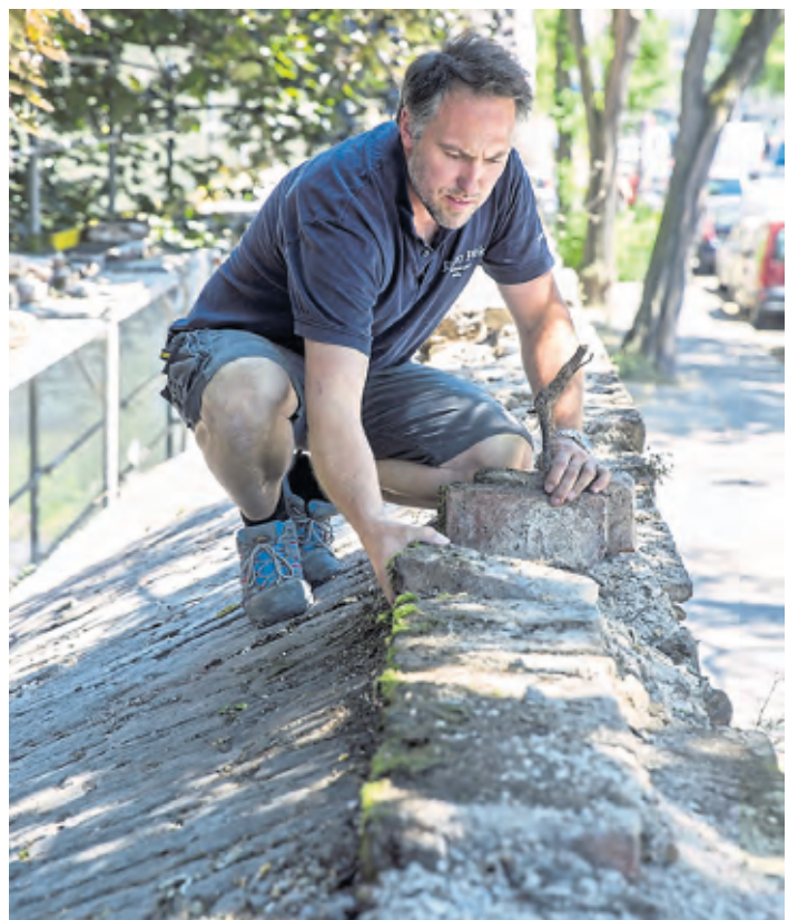
Teile der antiken Stadtmauer werden restauriert. Foto: M. Bause
