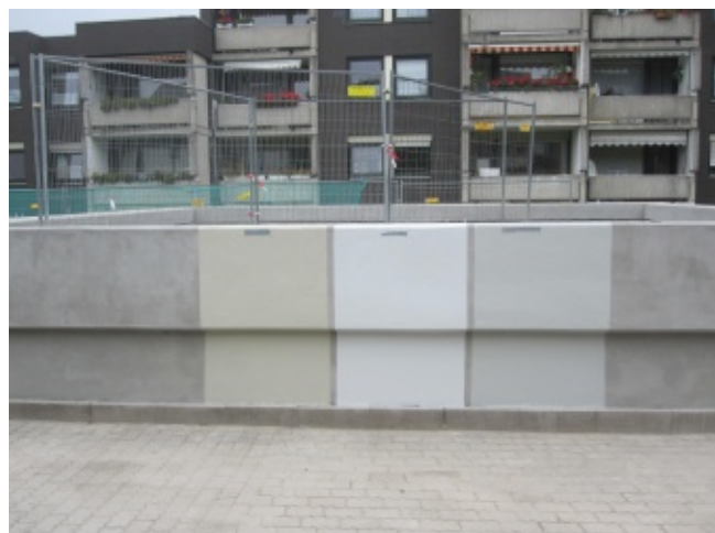
Reprofilerte Fläche mit Farbmustern
