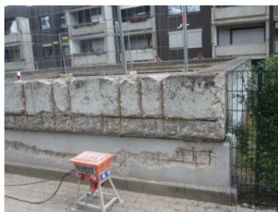
Freigelegte Betonstellen
