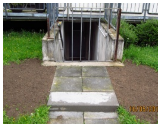
Nachher: Errichtung eines Podests für den sicheren Übergang
