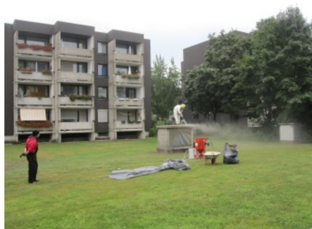
Strahlarbeiten an einem Lüftungskopf
