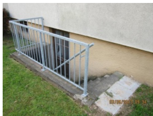
Nachher: Erneuerung des Kellerhalsgelanders unter Einhaltung der gültigen Vorschriften.
