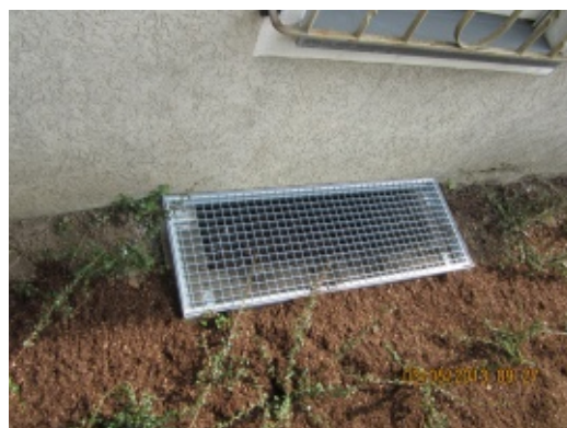
Nachher: Montage von Lichtschachtgittern
