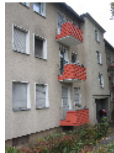
Balkonsanierung Adolf-Friedrich-Straße fertige Maßnahme
