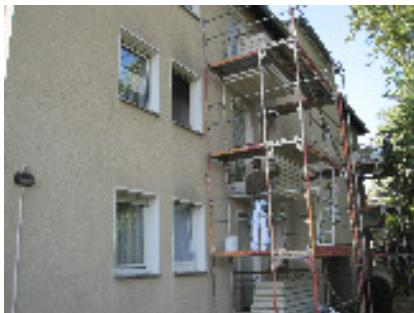
Balkonsanierung Adolf-Friedrich-Straße Vorbereitung
