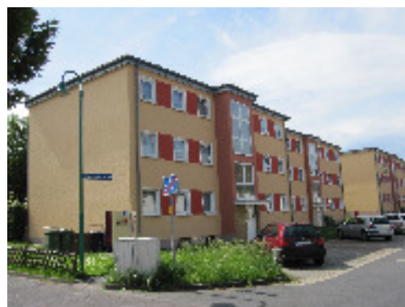
Königsberger Straße nach Fassadensanierung
