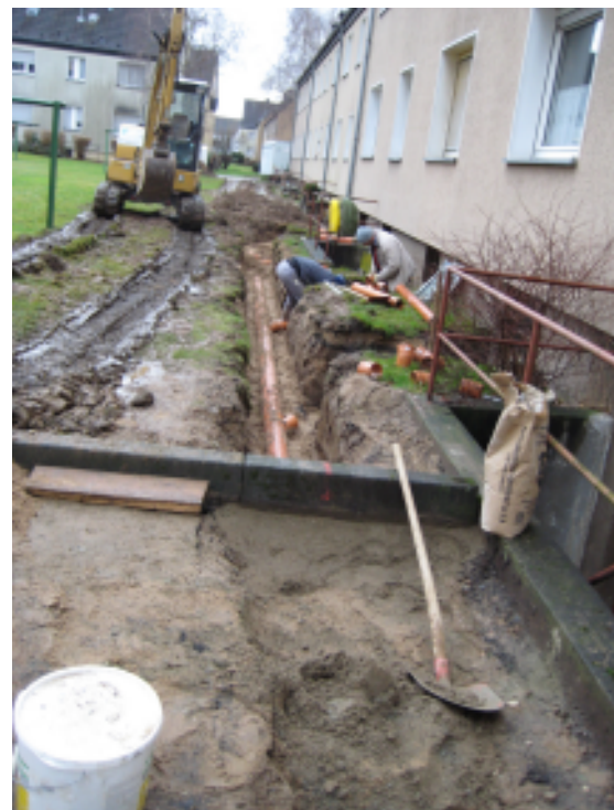
Kanalarbeiten in der Ringstraße
