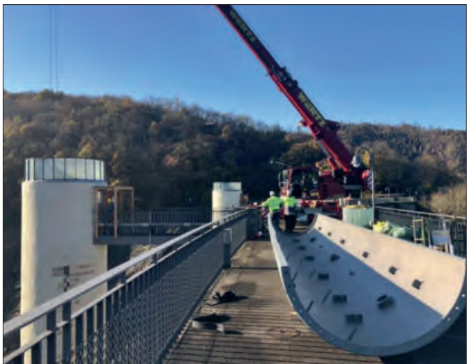
In einem aufwändigen Verfahren wurde die Ablasstürme an der Urftstaumauer geöffnet, um sie mit einem dicken Stahlrohr sicherer zu machen.
