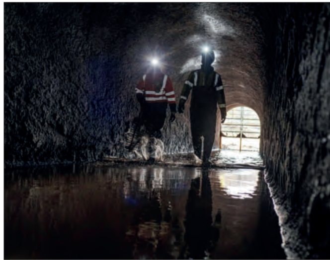
Spannende Inspektion des Stollens von innen. Diese Kontrolle muss alle 20 Jahre erfolgen.
