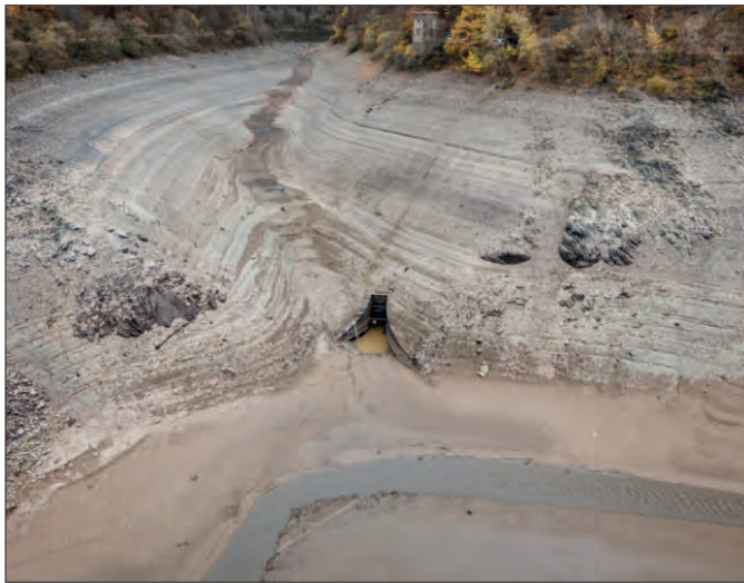
Das Wasser des Urftstausees wurde vollständig abgelassen, um den Wasserstollen zum Wasserkraftwerk kontrollieren zu können. In der Bildmitte befindet sich der Einlauf des Kermeter-Stollens, am oberen Bildrand das Schieberhaus des Südschachts.
