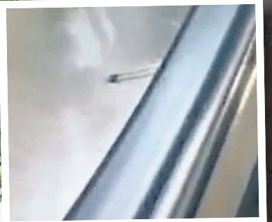
Gefährlich: Eine Fixerspritze mit offener Nadel direkt am Handlauf der Rolltreppe.
