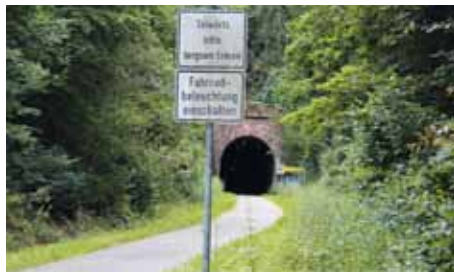
Vor dem Pleiner Tunnel
