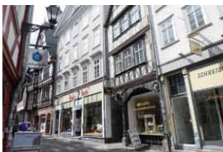
sanierte Fachwerkbauten, Altstadt
