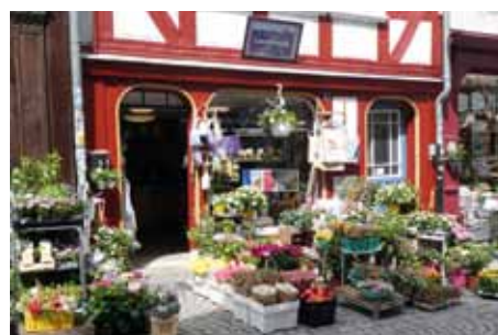
sanierte Fachwerkbauten, Altstadt
