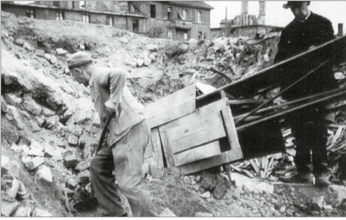
Arbeiter der Firma Deubner bei der Trümmerverwertung
