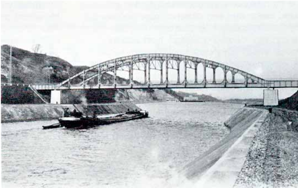
Erste Vierendeel-Träger-Brücke bei Visé-Lanaye (Baujahr 1930) über den noch im Bau befindlichen Albert-Kanal, entworfen vom belgischen Ingenieur Arthur Vierendeel (1852-1940), Foto aus dem Jahr 1935
