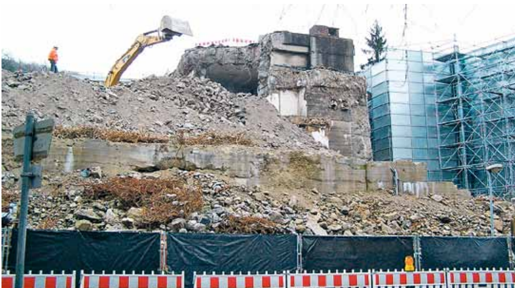
Abriss des Bunkers Rütcher Straße, Stand Ende Januar 2015
