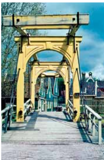
Zugbrücke an der Amstel
