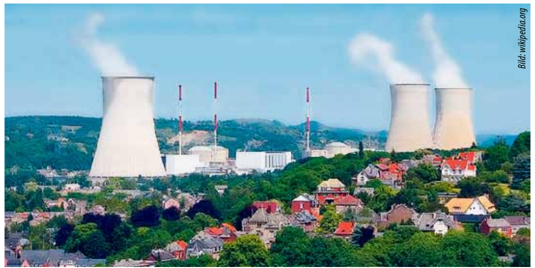
Das Atomkraftwerk Tihange 2009 in Betrieb
