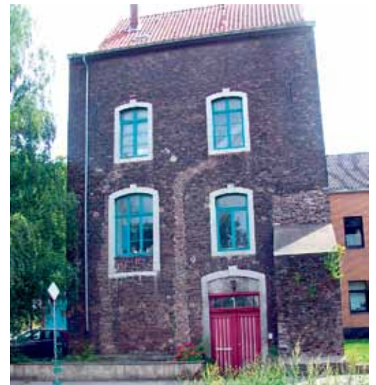
Pumpenhaus in Eschweiler-Pumpe-Stich, wo die erste Dampfmaschine im Aachener Revier stand
