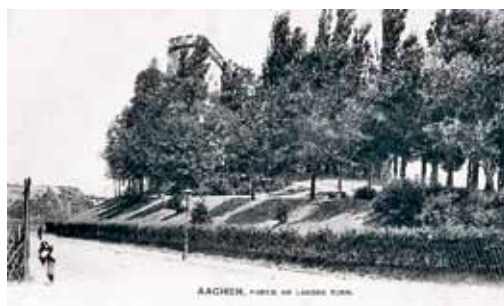
5454 Partie am Langen Turm
