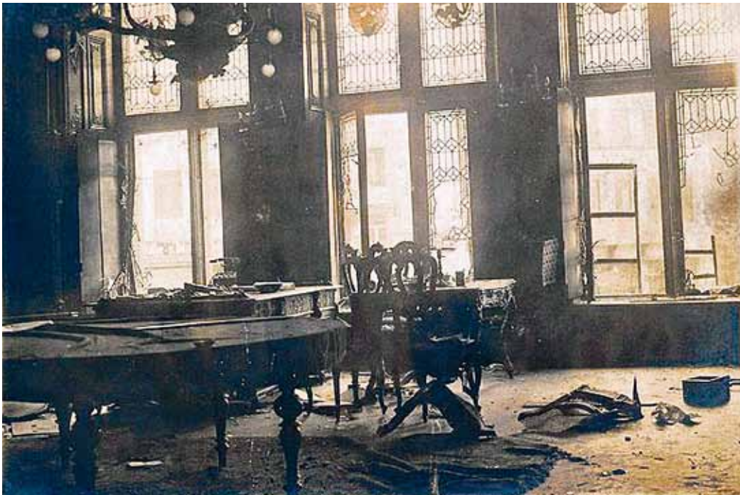
Verwüstungen im Inneren des Aachener Rathauses nach der Erstürmung durch die Separatisten
