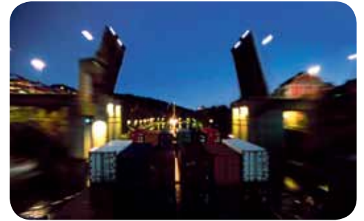
Einfahrt in die Schleuse Södertälje
