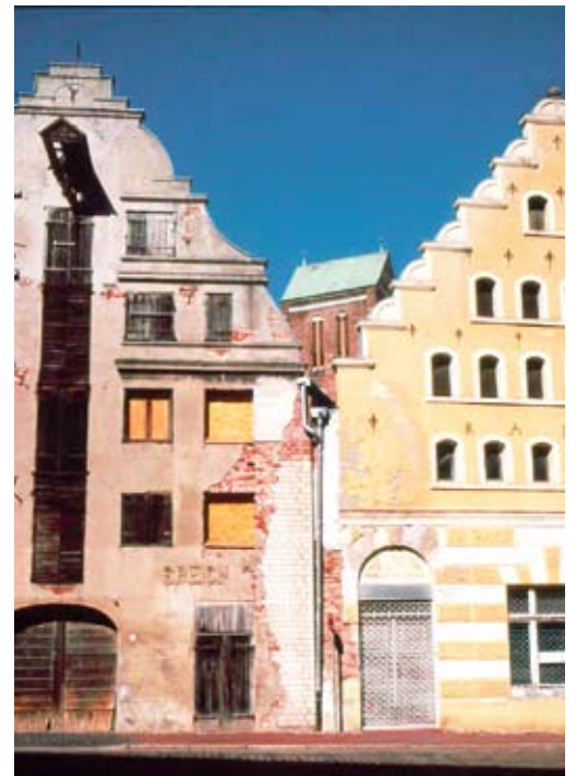
Nicht renoviert / renoviert
