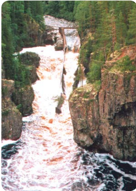
2 x der gleiche Gebirgsbach: Auf der Nordfahrt nach wenig Regen. Auf der Südfahrt hatte es heftige Gewittergüsse gegeben. Die künstliche Rinne ermöglichte es den Flößern, die Holzstämme am Wasserfall vorbei zu flößen, damit sie nicht den Flusslauf blockierten.
