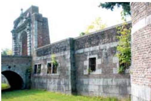
Portal und Brücke
