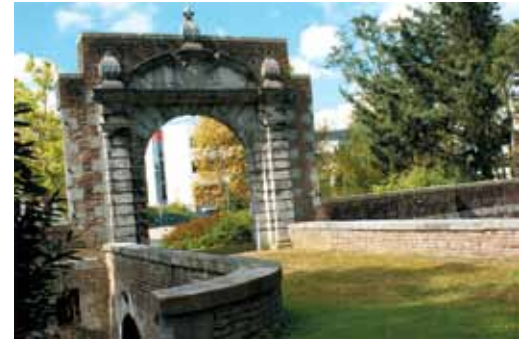
Portal und Brücke
