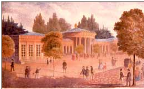
Der Eisenbrunnen von Südwesten
