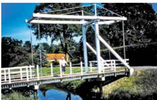
Fehnkanal mit Klappbrücke
