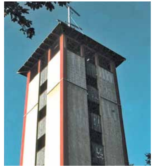
Ein wiederaufgebauter Turm
