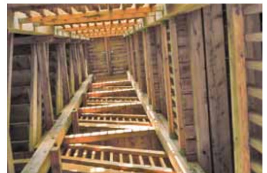
Der Holzturm von innen
