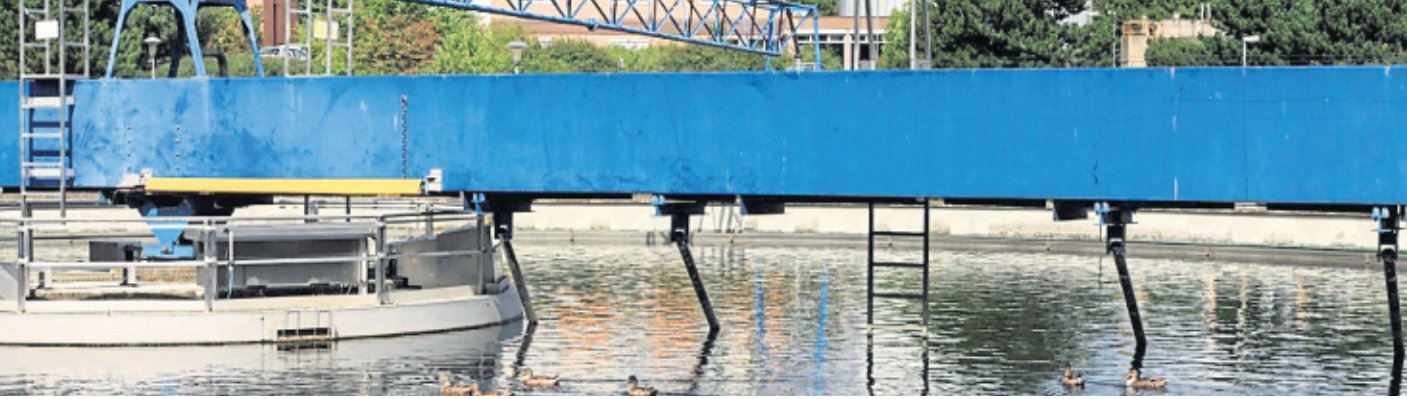
Klärschlamm ist ein Überbleibsel der Wassereinigung aus Kläranlagen wie dieser in Köln-Porz-Wahn. Der Schlamm soll ab 2025 in einer neuen Anlage in Merkenich verbrannt werden.
