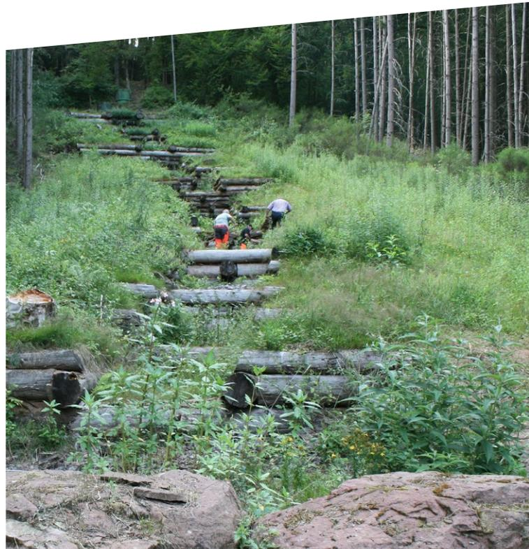
Holzkastensperren sind eine naturnahe Lösung zur Niederschlagsableitung und -versickerung und bieten somit Schutz bei Starkregen im ländlichen Raum.
