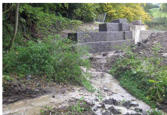
Weinsberger Bach: Renaturierungsmaßnahmen am Oberlauf
