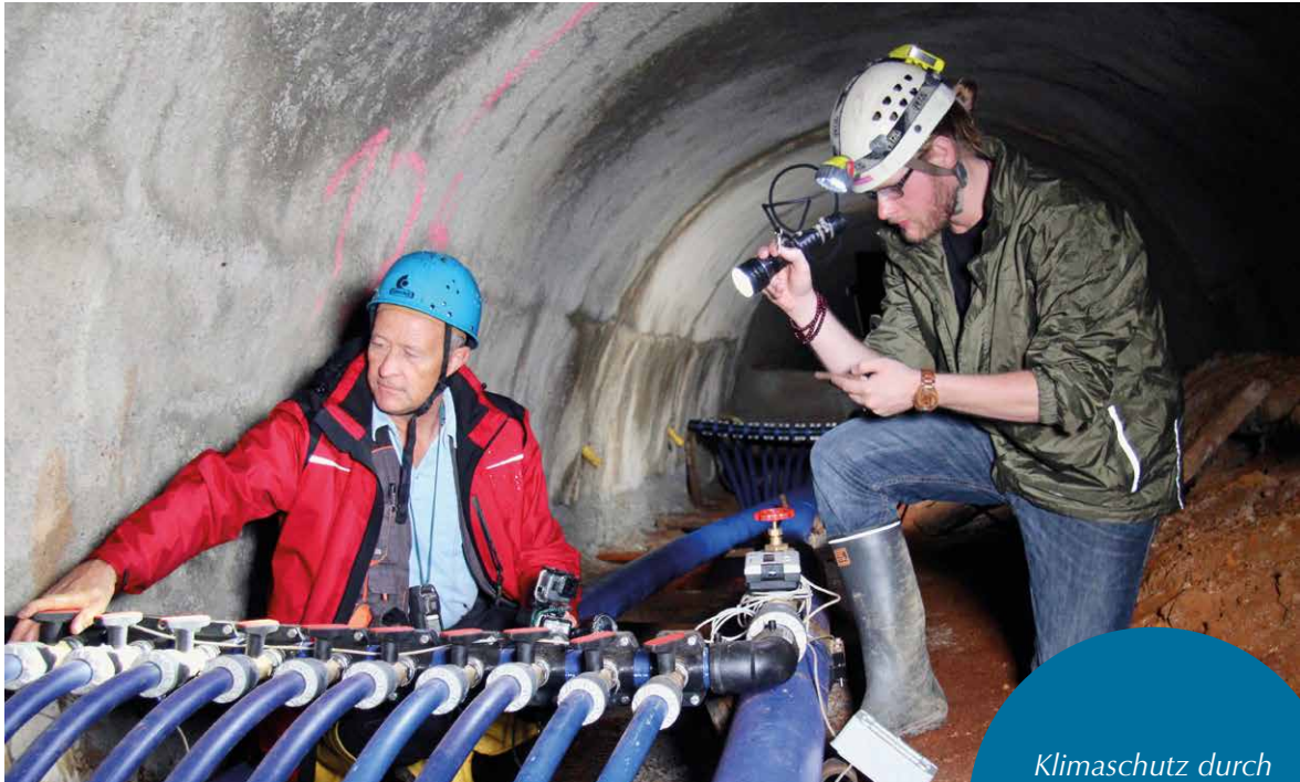
Überprüfung der Leitungen
