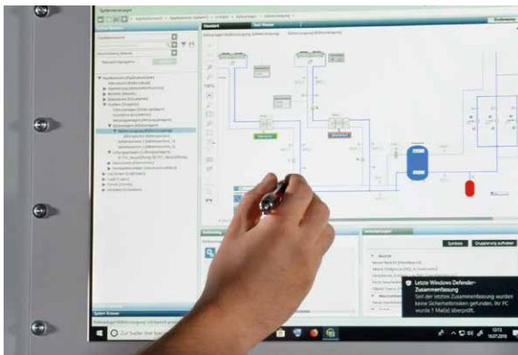
Energieverbräuche gezielt kontrollieren
