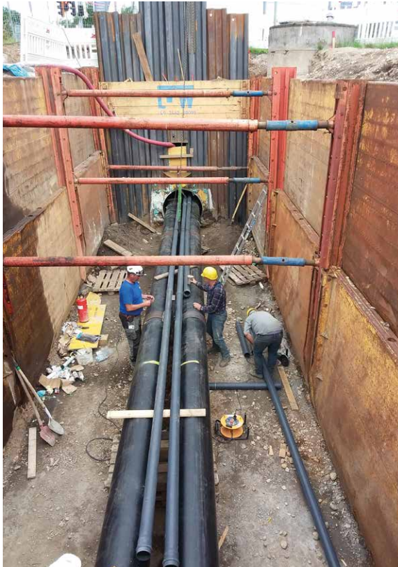
Bau eines Fernwärmenetzes
