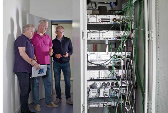
In Rechenzentren und Serverräumen stecken hohe Energieeinsparpotenziale
