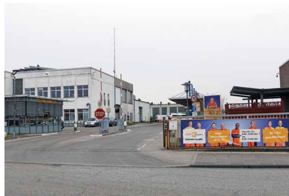
Außenansicht des Abfallwirtschaftsbetriebs Kiel
