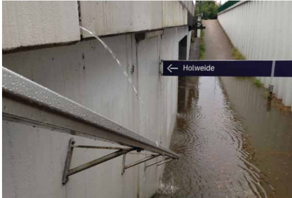
Folgen eines Starkregens
