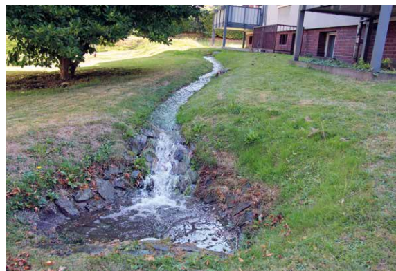
... kann oberirdisch über grüne Entwässerungsmulden ablaufen.
