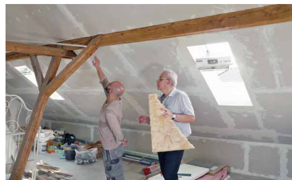
Erfolgreich energetisch sanieren
