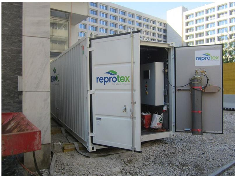
Abbildung 53: Container Abwasseraufbereitung der Firma Reprotex GmbH im Einsatz bei dem Rückbau eines Hochhauses [REP2020-2]
