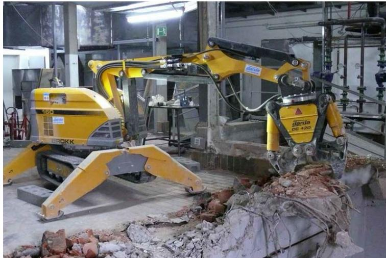
Abbildung 5: Darda GmbH: Abbruchzange CC420 [DAR2020]
