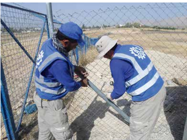
Arbeit soll sich lohnen – darum organisiert das THW in den Camps ein Cash-for-Work-Programm, das die Flüchtlinge beispielsweise für kleinere Reparaturmaßnahmen entlohnt. | Work deserves to be paid for – that is why THW has set up the “Cash for Work” scheme at the camps, giving their dwellers a chance to earn some money, for example by carrying out minor repair jobs.
