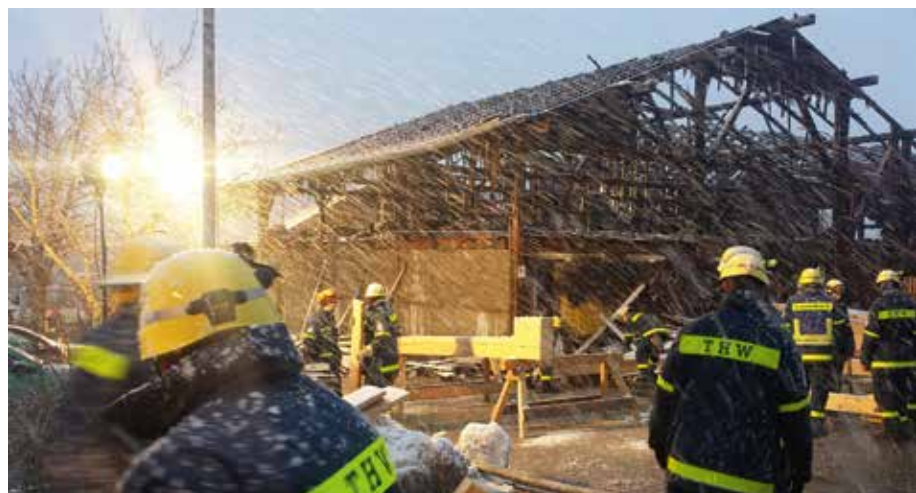
Mit dem ASH können THW-Kräfte instabile Wände und marode Decken nach Bränden oder Gasexplosionen abstützen – wie Anfang 2016 nach einem Werkstattbrand im bayerischen Machtlfing. | The ASH enables THW volunteers to shore up unstable walls and damaged roofs after fires or gas explosions – such as in early 2016, following a workshop fire in the Bavarian village of Machtlfing.
