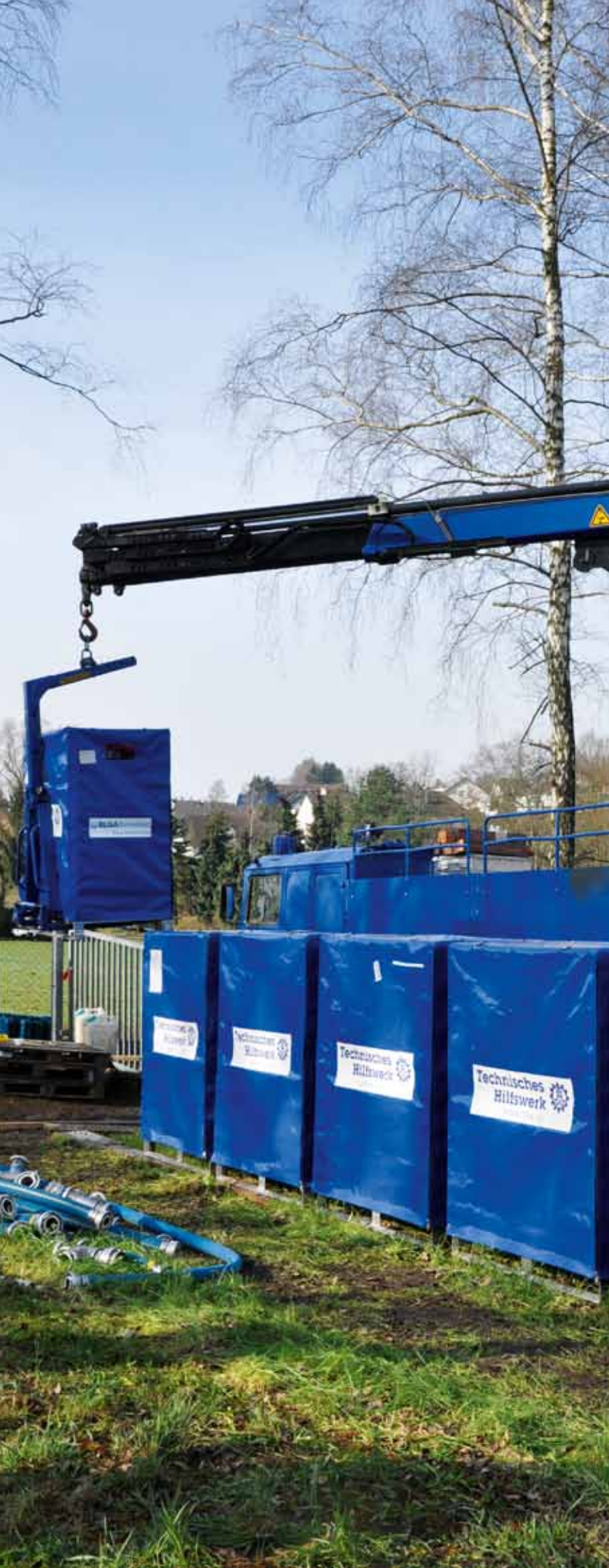
Aufbau einer Trinkwasseraufbereitungsanlage. 2010 bereitete das THW in Wetterau und Extertäl Wasser auf.
