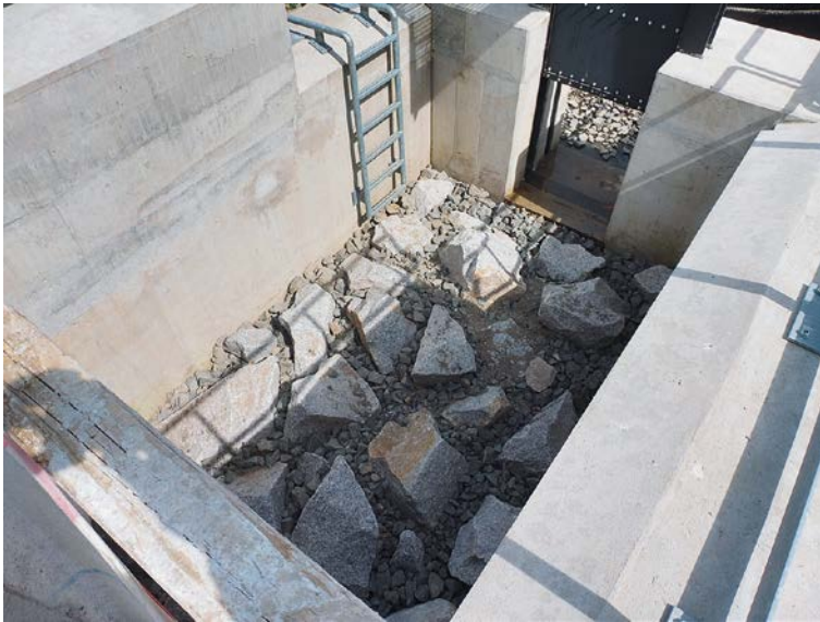
Einzelnes Schlitzpassbecken der FAA Malliß
