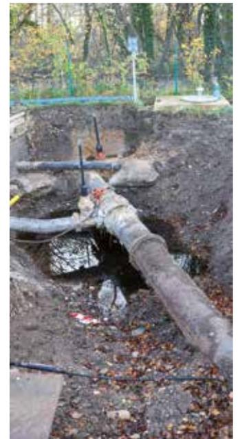
Nach der finalen Bohrung - das Bohrloch ist dann mit Betonit provisorisch verfüllt, damit nichts einbricht - wird die neue Leitung mit dem Zurückholen des Bohrgestänges durch die Bohrung gezogen.
