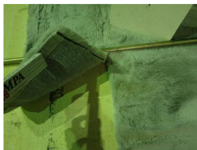
Abbildung 6-21: Detail der Stoßfuge beider Teppichstücke
