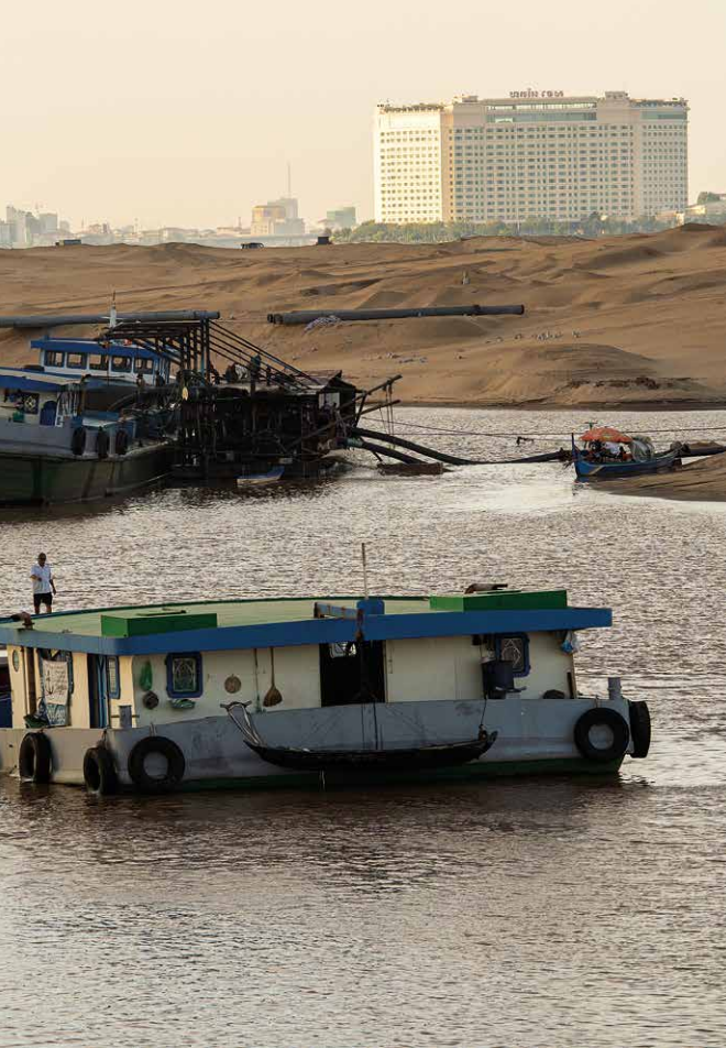
Der Sand wird mit Wasser vermischt und dann von den Kähnen durch Schläuche auf die Fläche gepumpt, wo Land gewonnen werden soll (Foto: Thomas Cristofolletti / Ruom).
