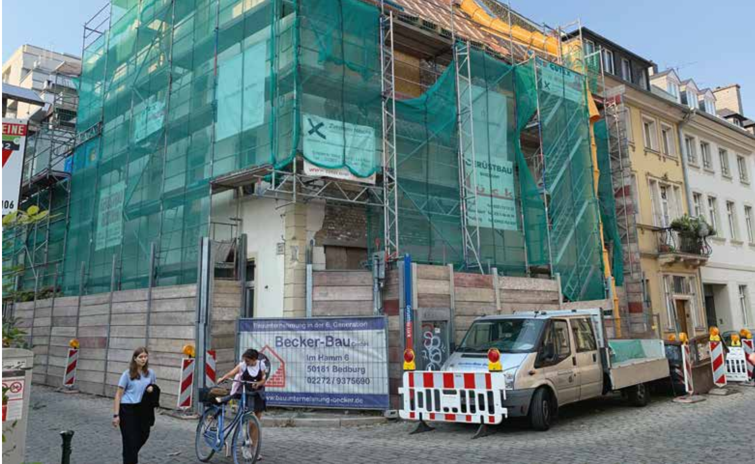
Sanierung eines Hauses in der Düsseldorfer Altstadt
