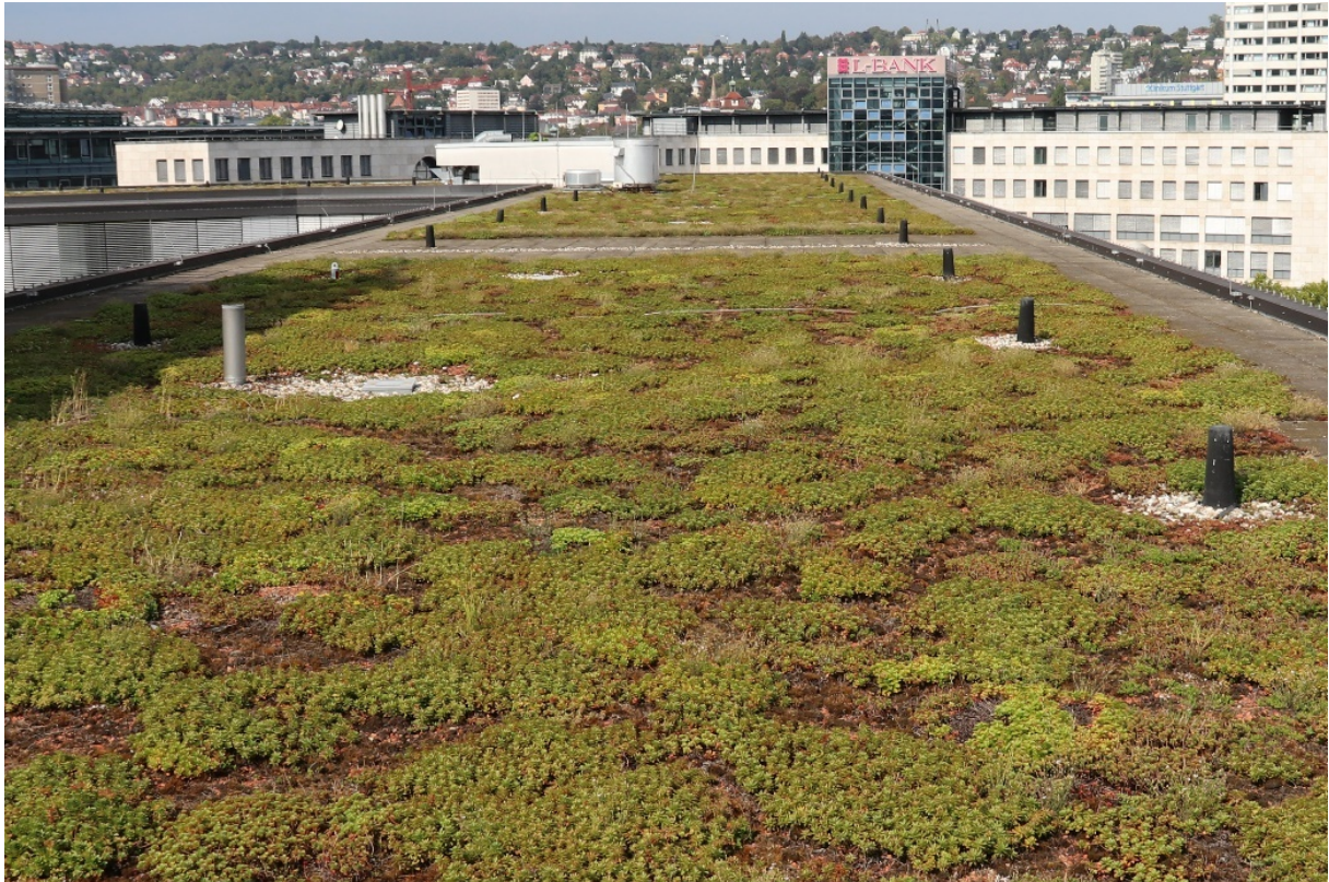
Abbildung 8 Retentionsdach (© Susanne Herfort)
