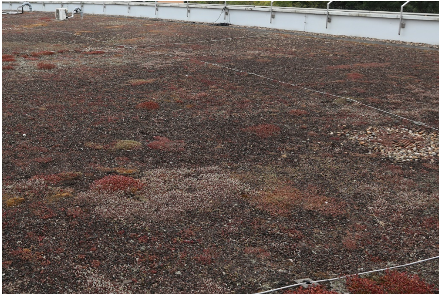
Abbildung 22 Dachbegrünung mit Substrat C (max. Wasserkapazität 26 %) aufgenommen am 13.09.2018 in Berlin (© Susanne Herfort)
