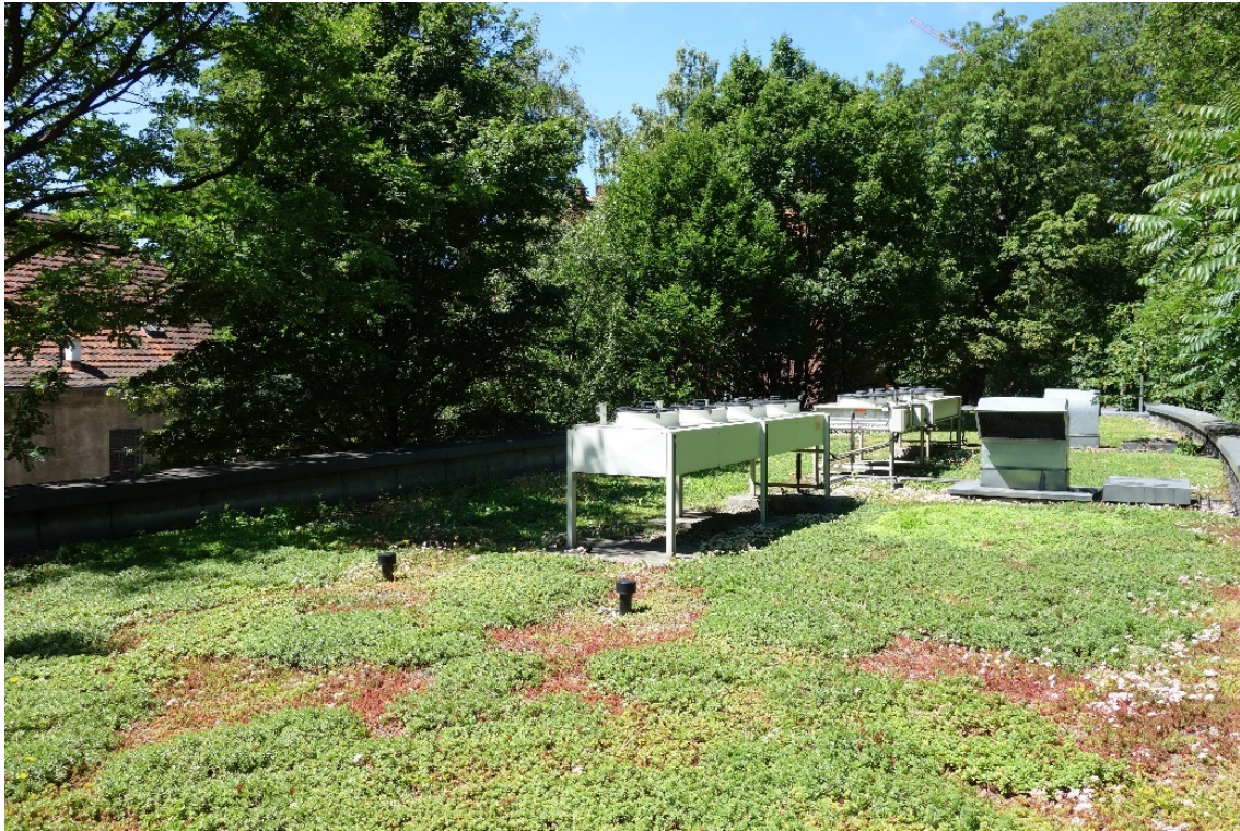
Abbildung 53 Regelmäßig gepflegte Dachbegrünung mit Sedum-Vegetation (© Susanne Herfort)
