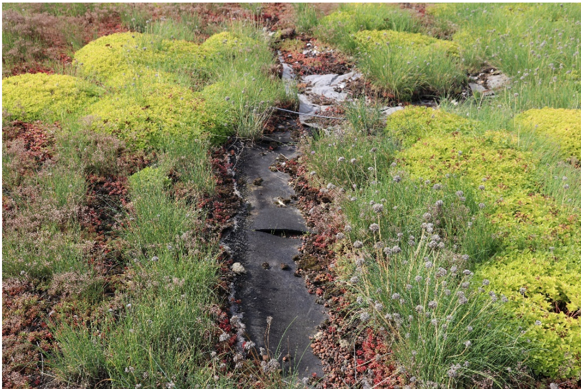
Abbildung 46 Freigelegte wurzelfeste Folie, die schnellstmöglich mit Substrat und Vegetation wieder abgedeckt werden muss. (© Susanne Herfort)
