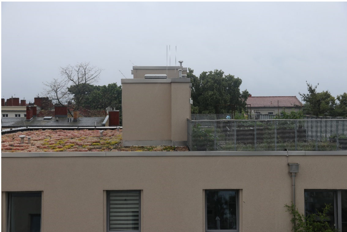
Abbildung 67 Extensive Dachbegrünung mit Moos-Sedum und Mietergarten mit Hochbeeten auf demselben Dach (© Susanne Herfort)
