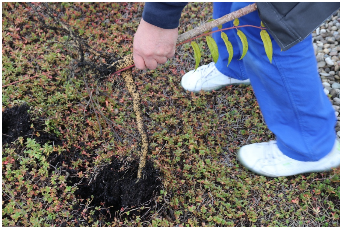
Abbildung 39 Gehölze mit aggressivem Wurzelwachstum müssen ebenfalls entfernt werden. (© Susanne Herfort)
