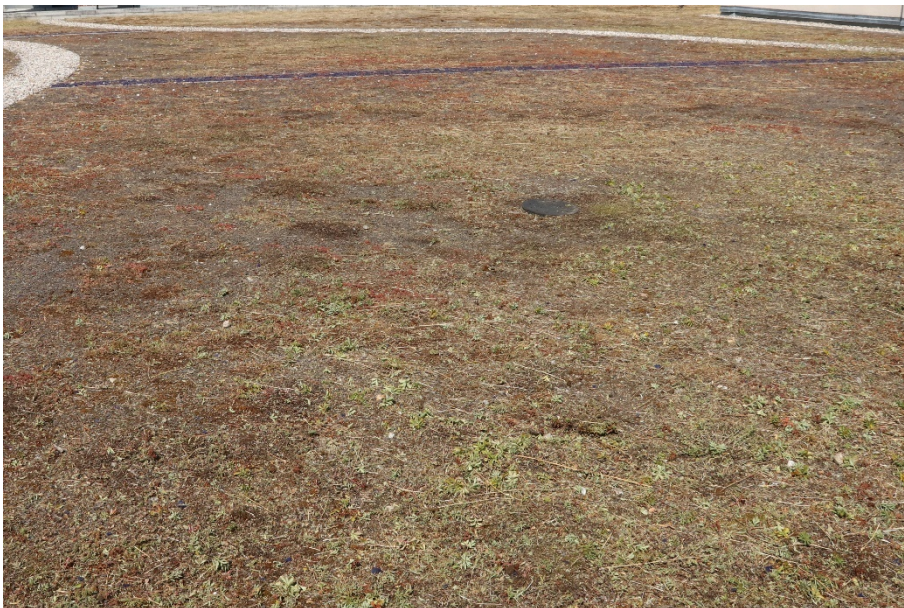
Abbildung 21 Dachbegrünung mit Substrat B (max. Wasserkapazität 50 %) aufgenommen am 16.08.2018 in Berlin (© Susanne Herfort)
