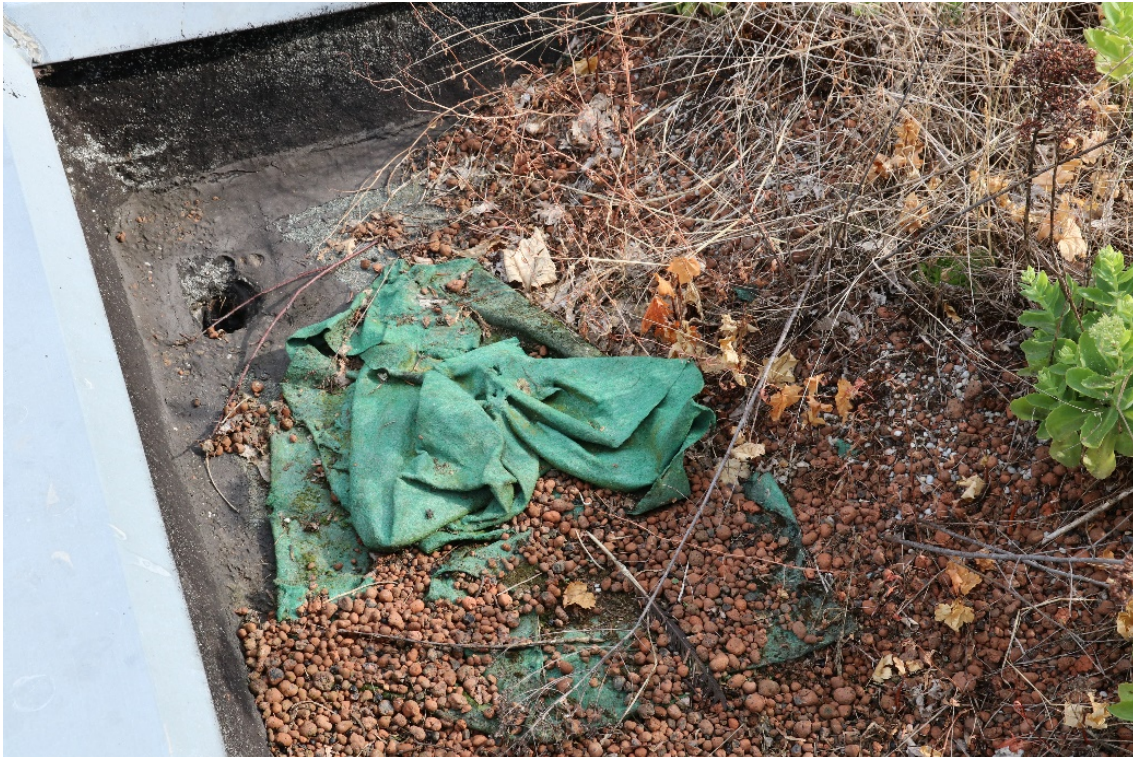
Abbildung 47 Reparatur der Dachabdichtung ohne Rekonstruktion der Dachbegrünung, hier muss eine Sanierung des Dachbegrünungssystems durch eine Firma erfolgen. (© Susanne Herfort)
