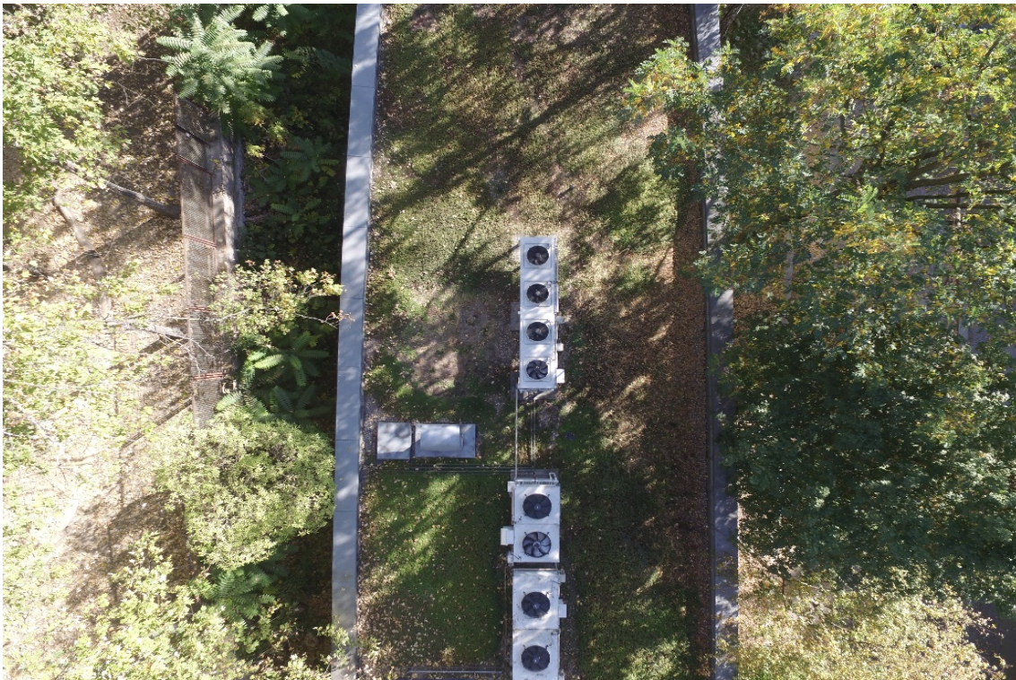
Abbildung 65 Draufsicht der Dachbegrünung; Schattenwurf und Fehlstellen in der Vegetation können sofort festgestellt werden (© Benjamin Herfort)
