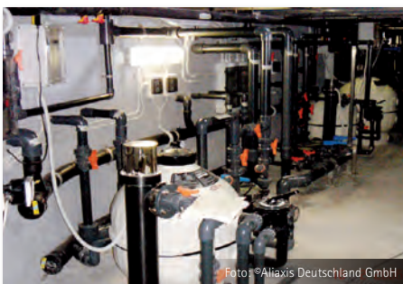
Entsalzungsanlage mit Rohren und Formteilen aus PE100
