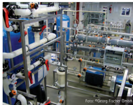
Entsalzungsanlage mit Rohren und Formteilen aus PE100
