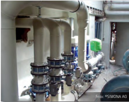
Attraktionsverteiler mit Rohren und Formteilen aus PP-H in einer Wasseraufbereitungsanlage
