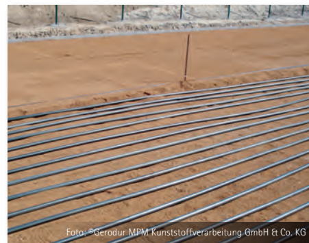
Installation des Wärmetauschers
