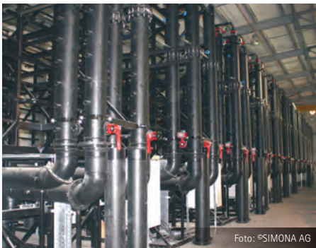
Entsalzungsanlage mit Rohren und Formteilen aus PE100
