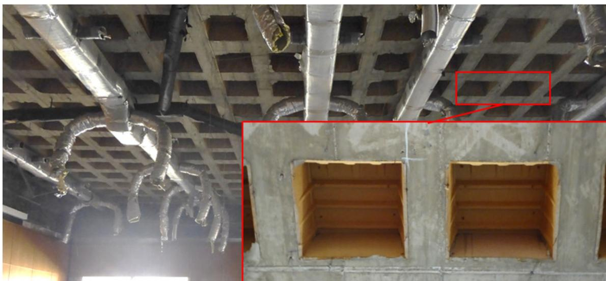
**Abbildung 5.** Herausforderung der getrennten Erfassung: Verlorene Schalung mit Holz- und Styroporresten in der Betonkonstruktion (Rippendecke des Ratssaals). Quelle: Fotografin Dilan Glanz.
