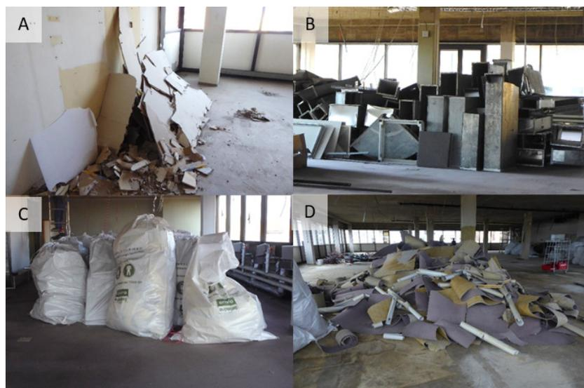
**Abbildung 4.** Beispiele für separat gelagerte Fraktionen aus dem Schadstoffausbau und die Entkernung (A) Rigips Platten (B) Metall (Lüftung) (C) KMF-Dämmmaterial (D) gemischte Bauabfälle. Quelle: Fotografin Dilan Glanz.
