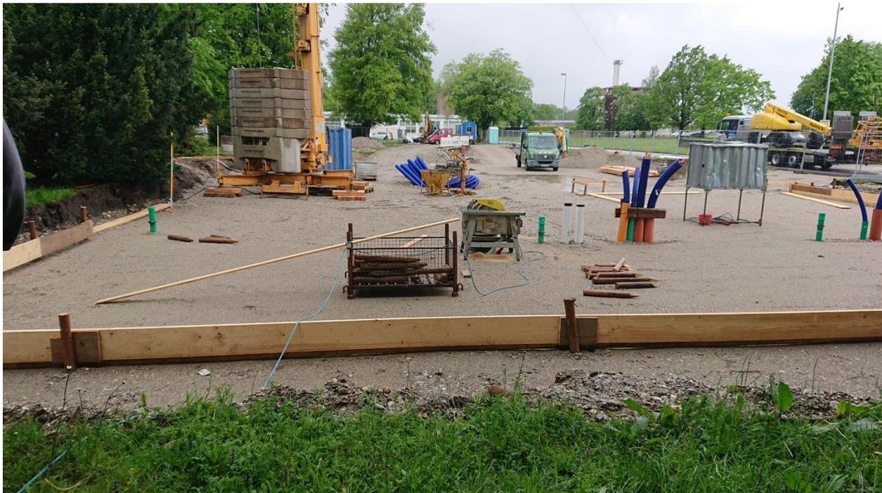
Abbildung 1: Das Planum für die Bodenplatte ist erstellt.
