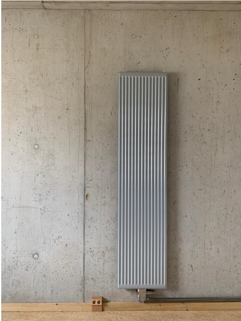
Abbildung 18: Die Heizkörper sind dicht am Vertikalstrang der Technik platziert und hochformatig, um viel Wandfläche für Möbel zu belassen.
