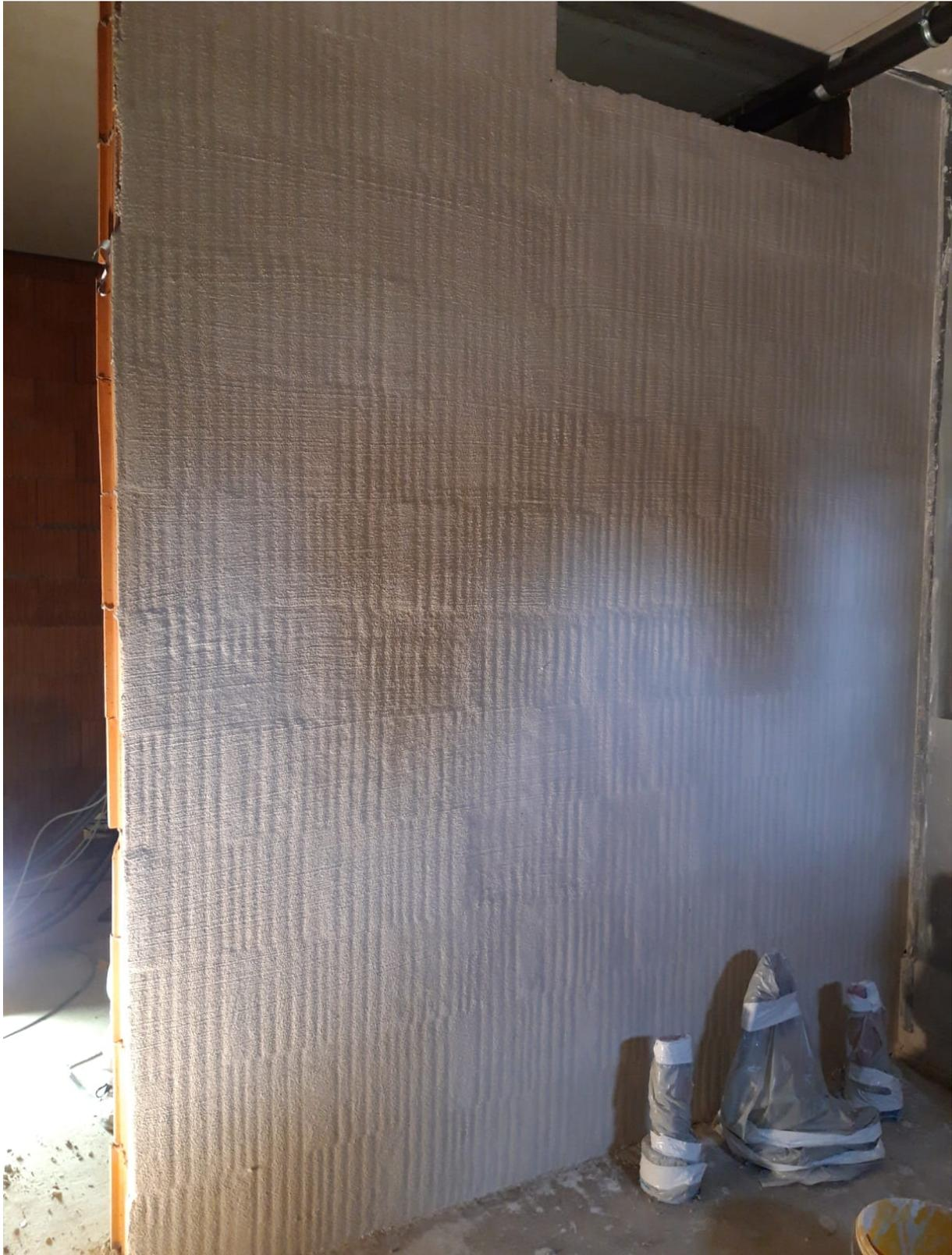
Abbildung 61: Die Kalkschlämme auf der Innenwand wird getestet.
