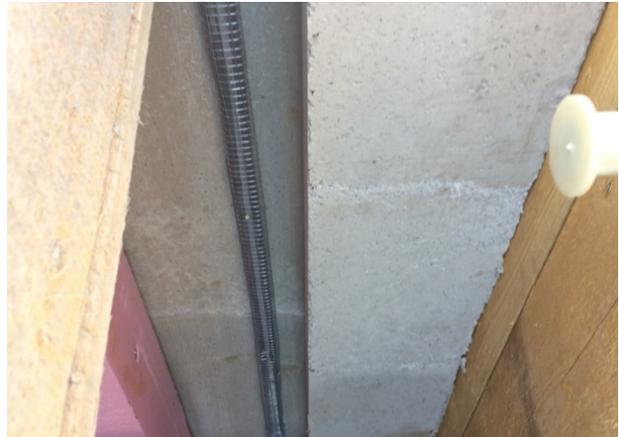
Abbildung 8: Um die Rissbildung durch das Schwinden und Krieche des Infraleichtbetons gering zu halten, wurde in versetzten Abschnitten betonierte.
