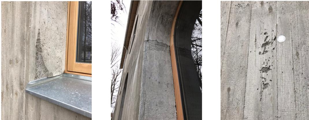
Abbildung 86: Kantenabbruch im Eckbereich (links), Abplatzungen (Mitte) und Fugenausprägung zwischen Betonchargen (rechts)
