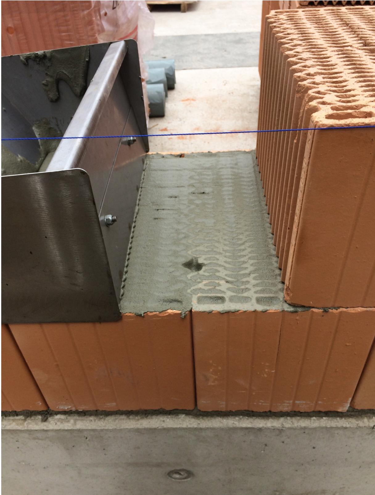
Abbildung 54: Die Luftkammern werden in jeder Steinlage mit einer Mörtelschicht verschlossen, um eine Zirkulation über die Steinlagen hinweg zu vermeiden.
