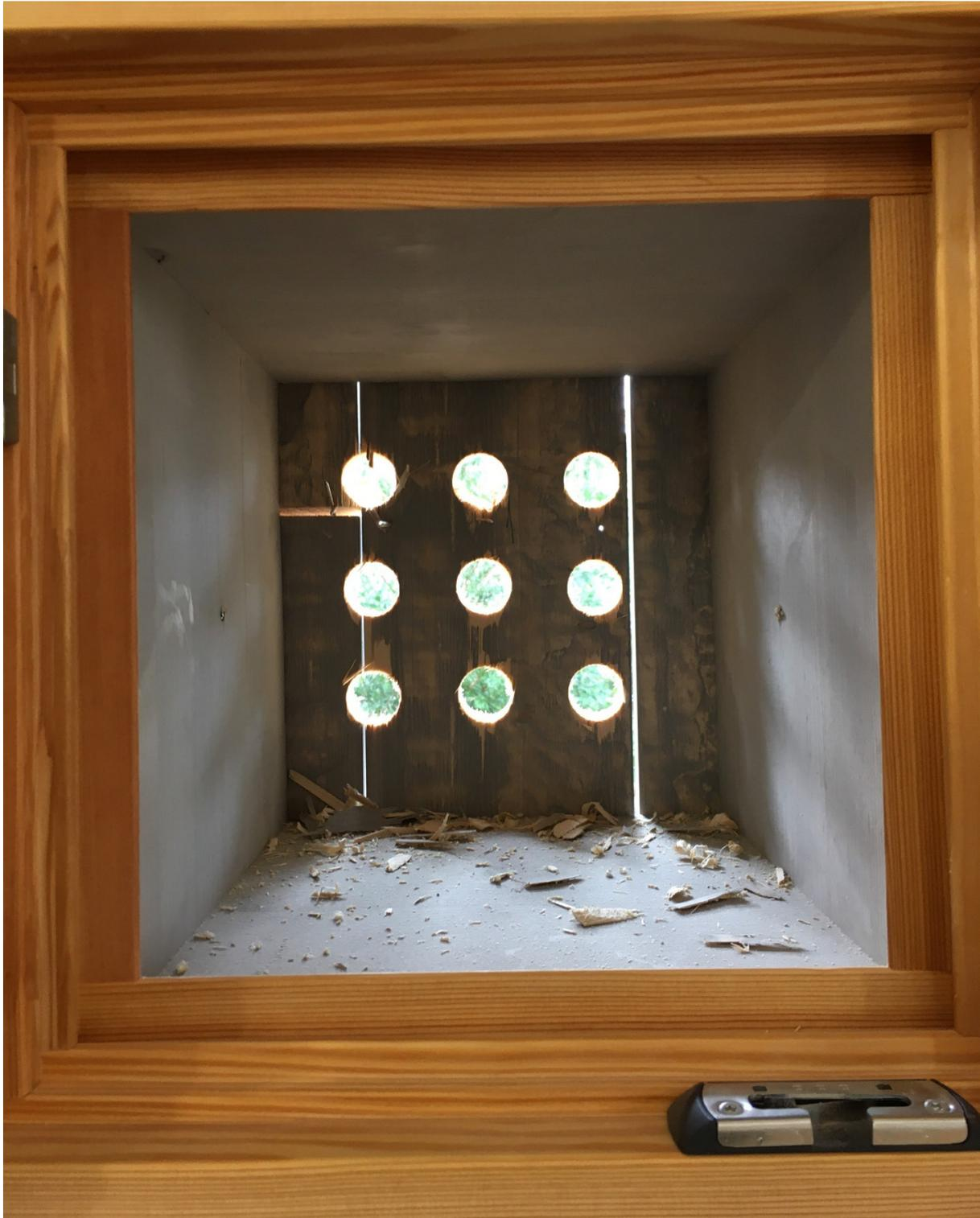
Abbildung 48: Eine der Lüftungsöffnungen der Speisekammern.
