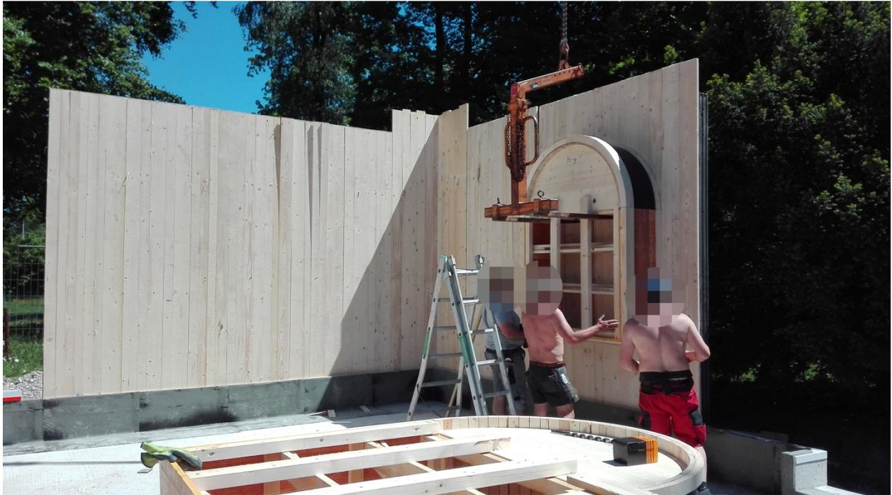
Abbildung 3: Die Schalung für die erste Infrleichtbeton-Wand wird aufgestellt.
