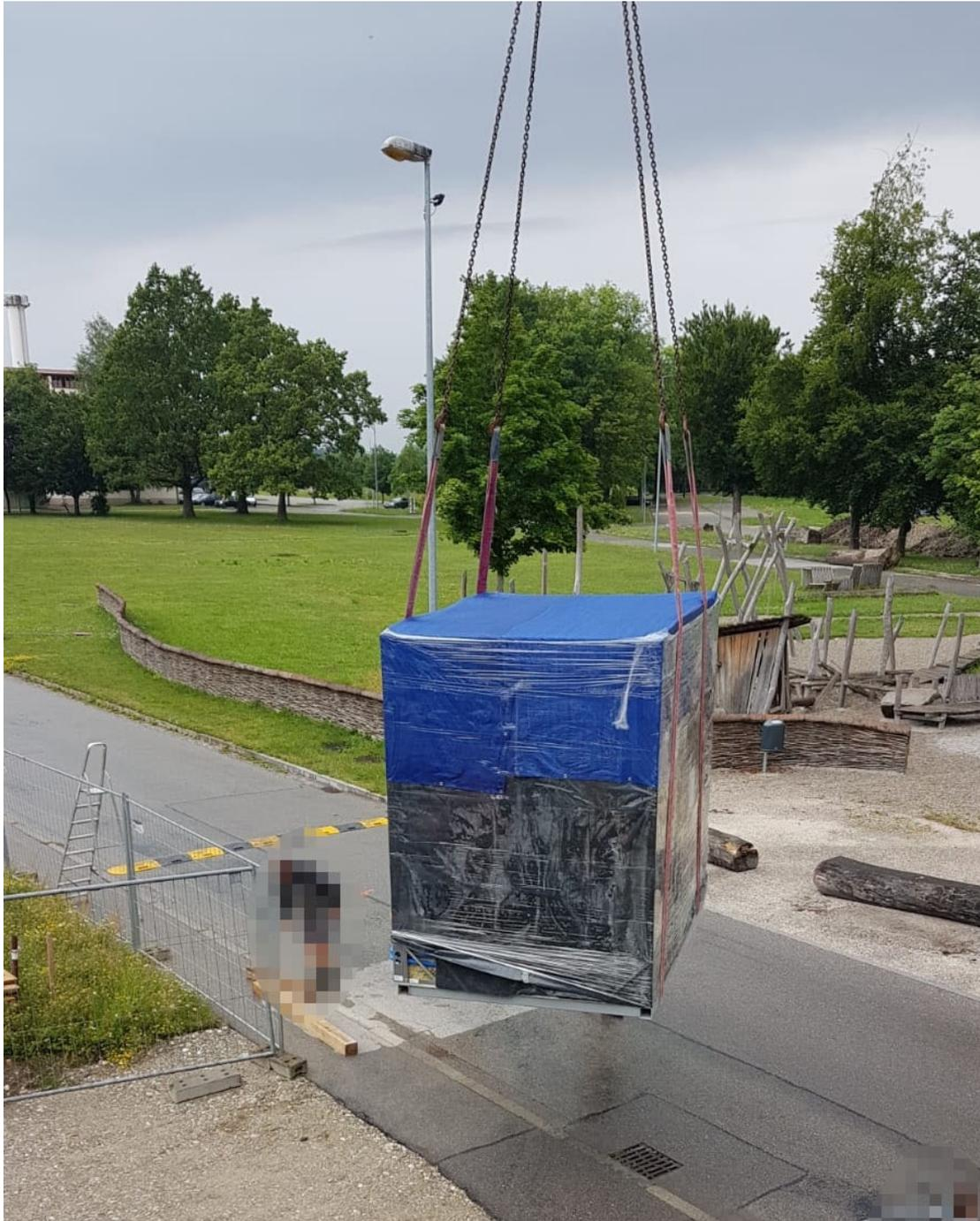
Abbildung 9: Eine vorgefertigte Badzelle wird in den Rohbau eingebracht. Sämtlich Bäder wurden in allen drei Forschungshäusern vorgefertigt.
