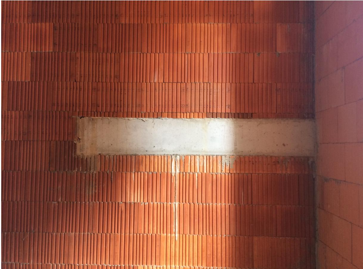
Abbildung 60: Auflager des Treppenpodests auf der tragenden Innenwand
