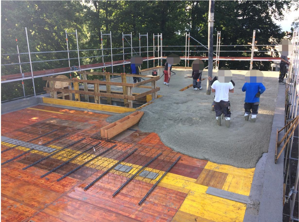
Abbildung 10: Die Decken wurden ebenfalls mit Stahlfaserbeton hergestellt.
