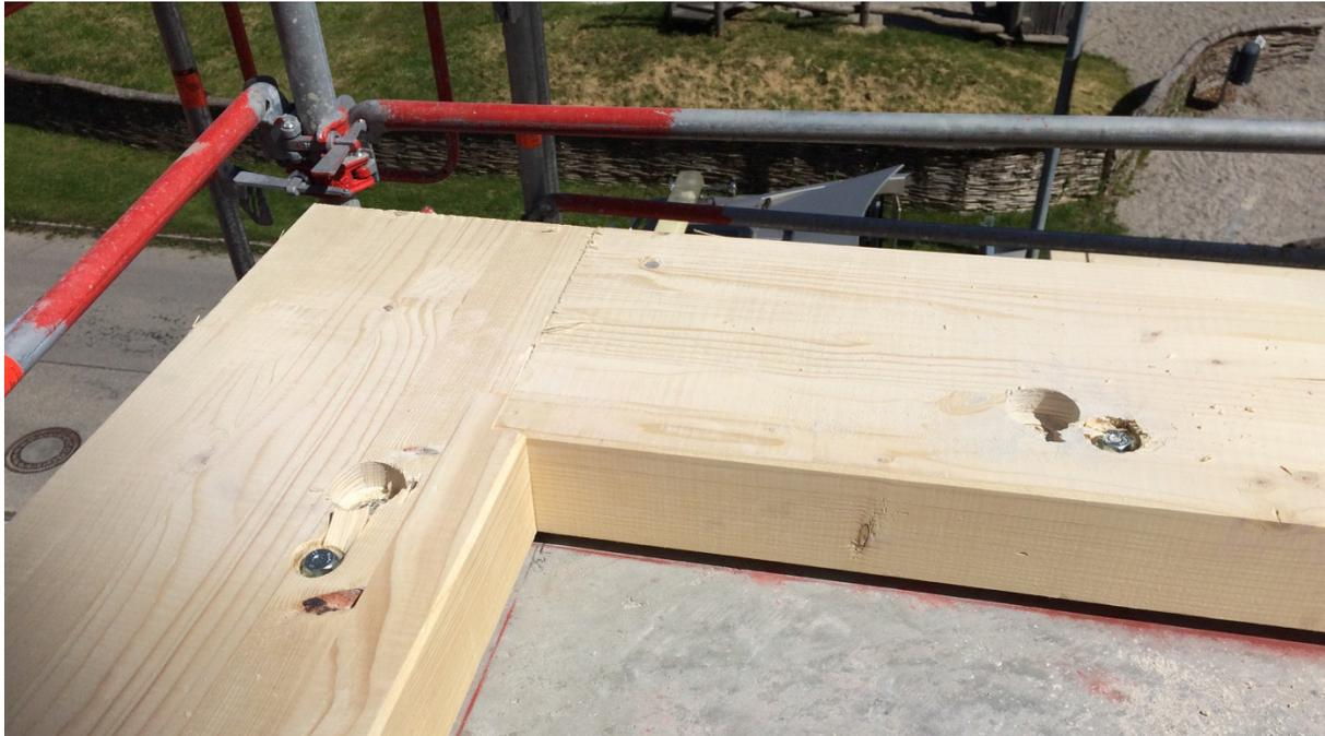
Abbildung 34: Die Holzprofile, auf denen die Außenwände lagern, werden in Lage und Höhe ausgerichtet und in der Betondecke verschraubt.
