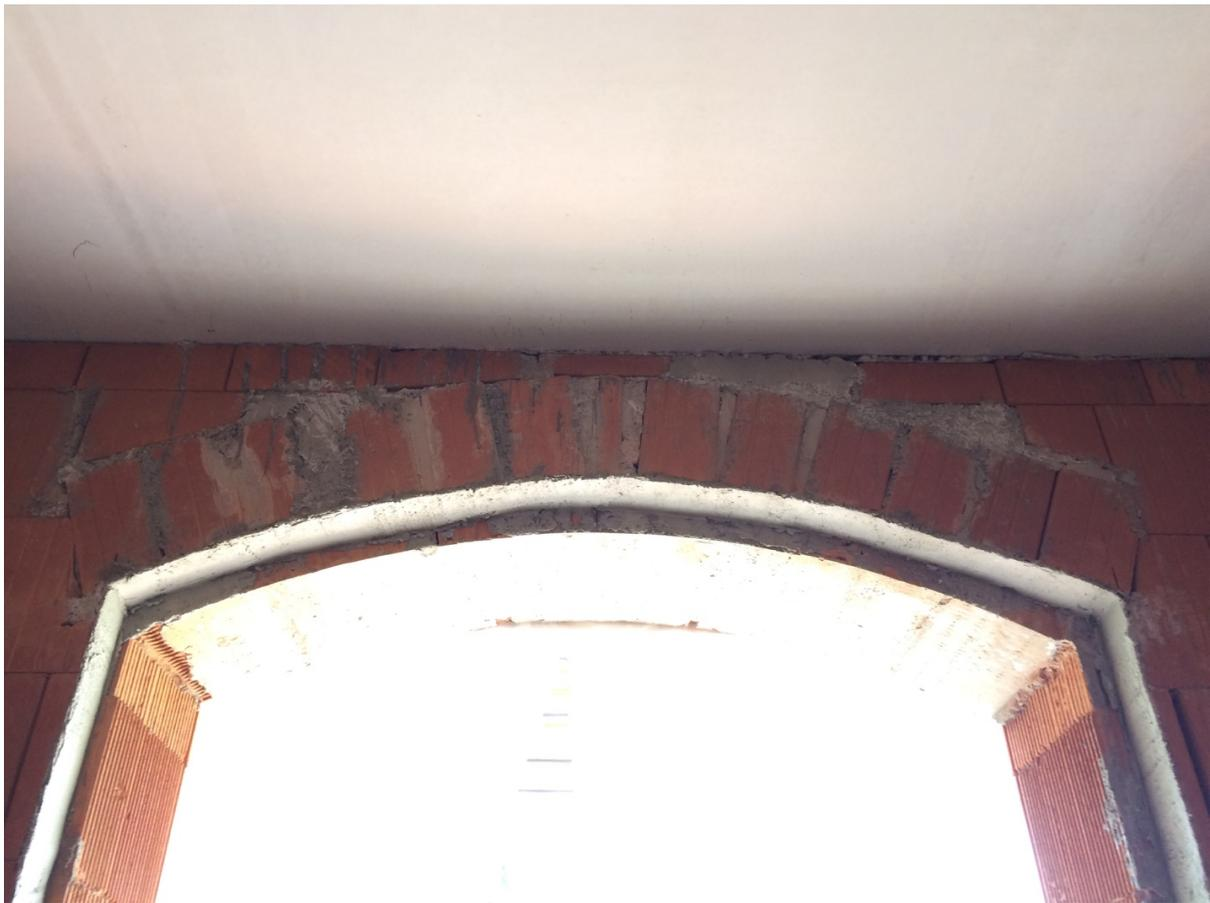
Abbildung 62: Der Anschlag für die Fenster ist hergestellt.
