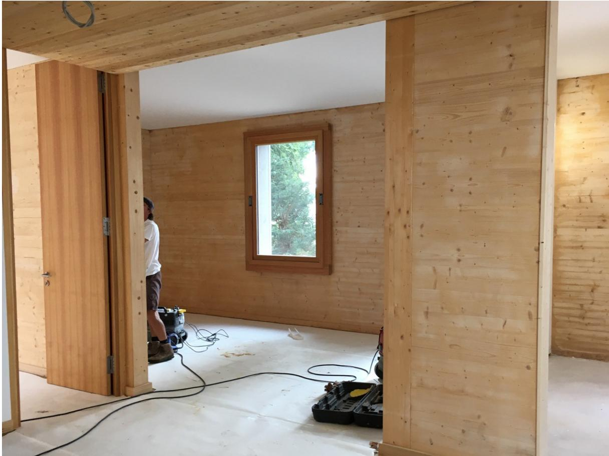
Abbildung 47: Da die Holzoberflächen durch Regen und Betoniervorgang doch hier und da gelitten haben, wurde dort Trockenbauschleifgerät nachgeschliffen.
