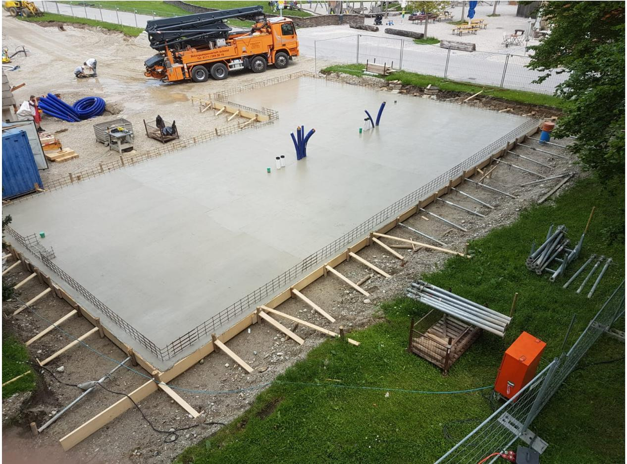
Abbildung 2: Die Bodenplatte ist betoniert.
