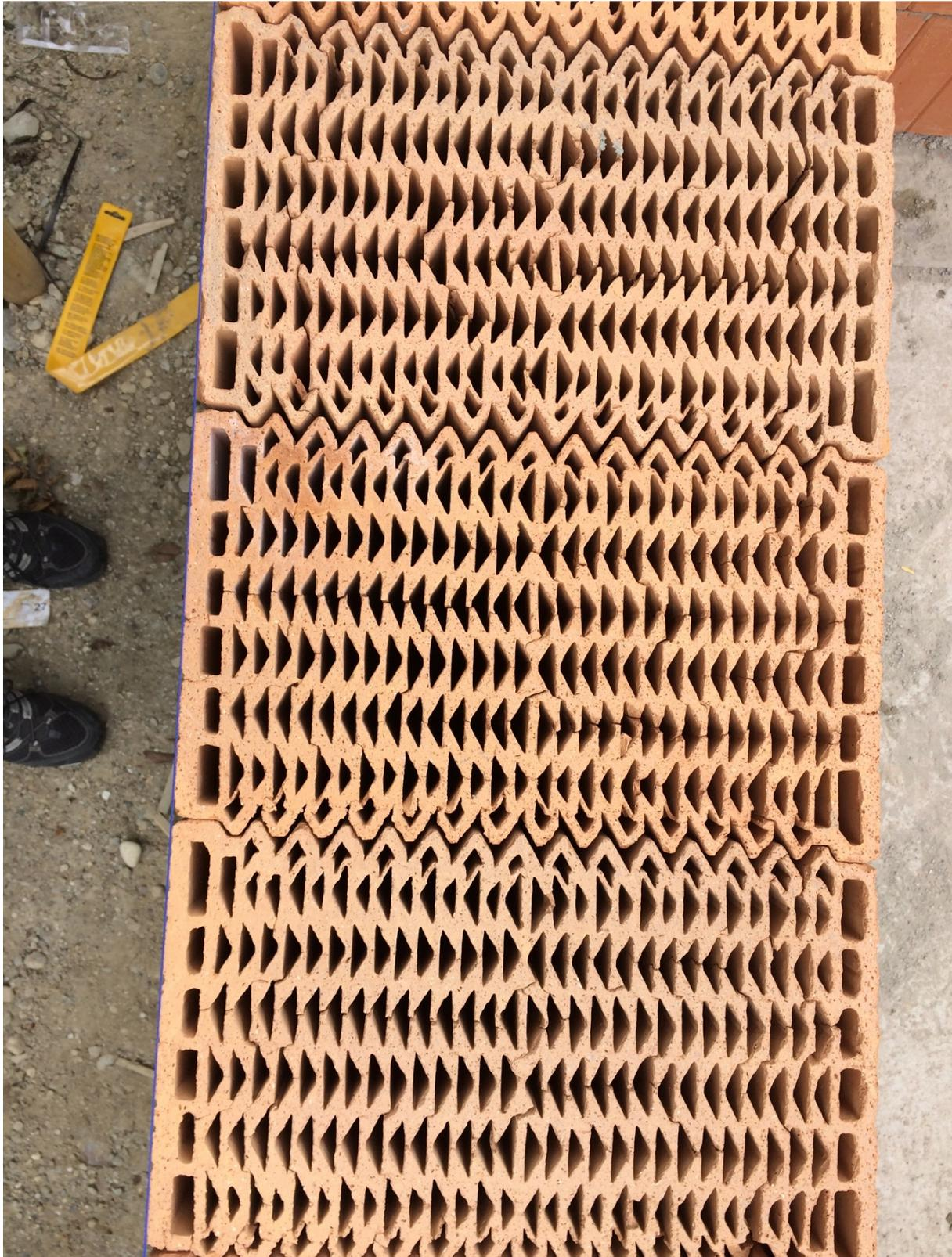
Abbildung 53: Die Luftkammerziegel werden ohne vertikale Mörtelfuge gesetzt.
