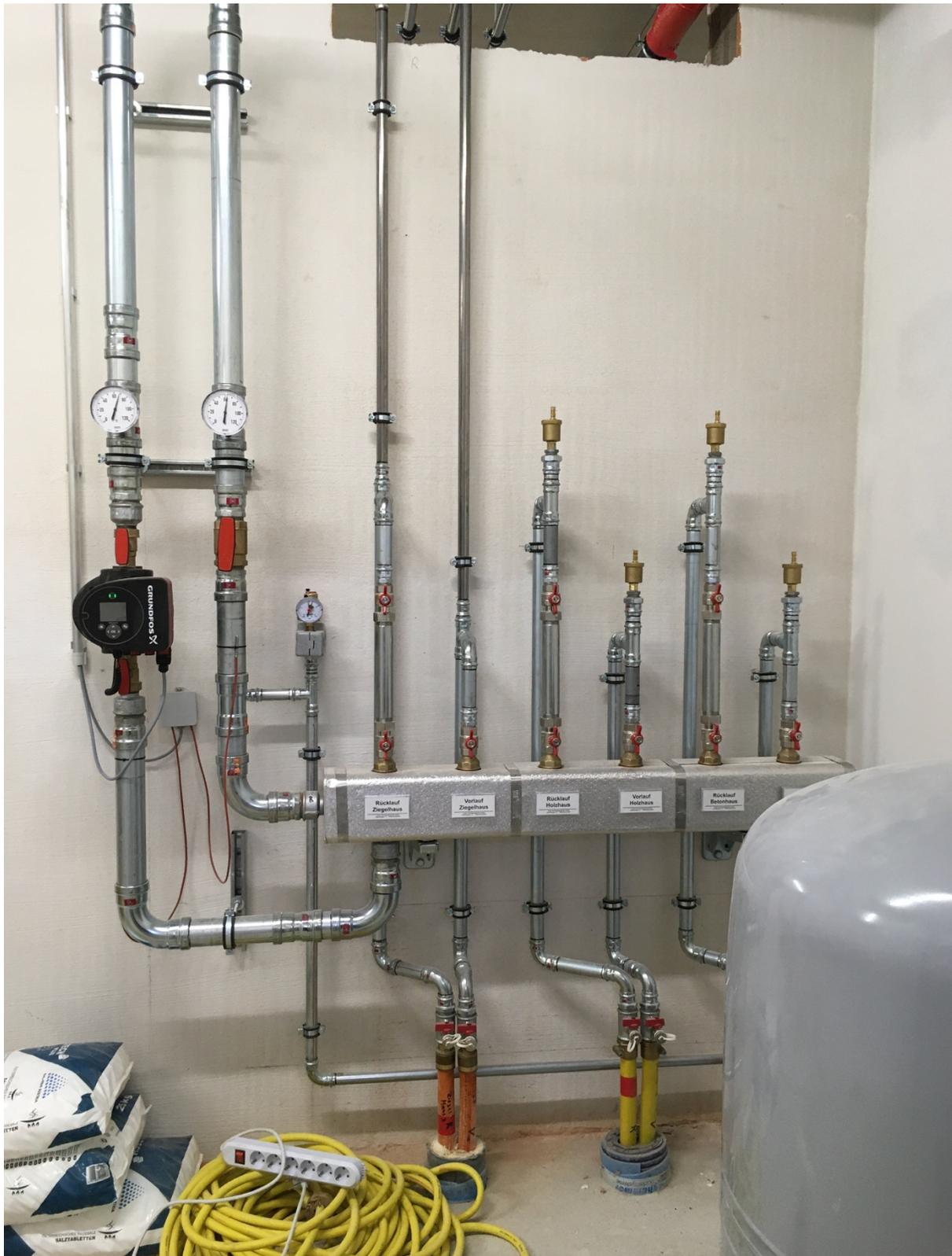
Abbildung 65: Hier erfolgt die Verteilung der Wärme für Heizen und Warmwasser in die drei Häuser.
