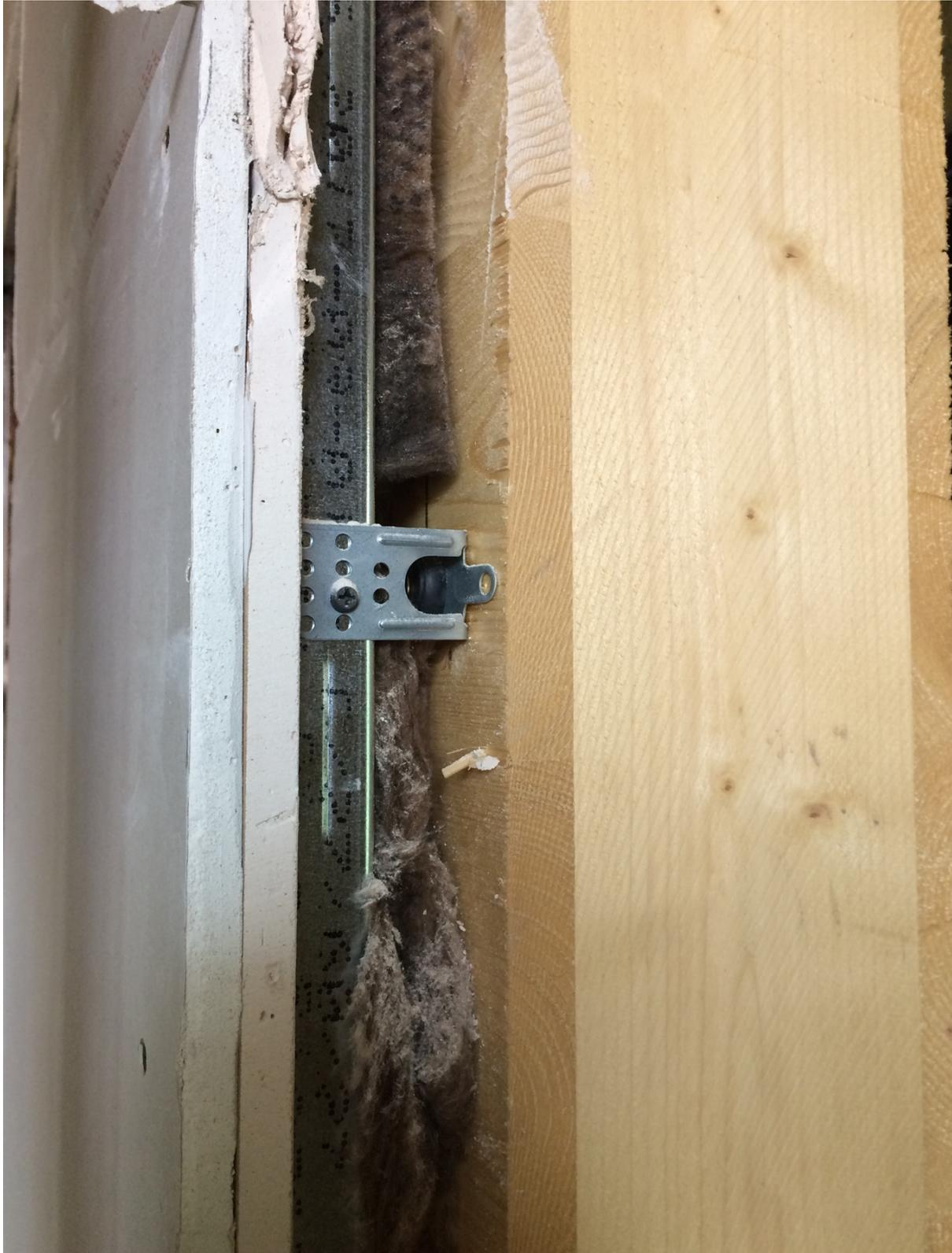
Abbildung 43: Die Wohnungstrennwände werden mit einer zusätzlichen Schicht aus Leichtbauplatten verkleidet, um die notwendigen Schallschutzwerte zu erreichen.
