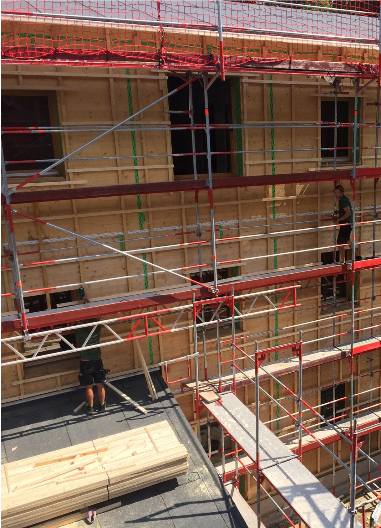
Abbildung 46: Die Unterkonstruktion der Holzverschalung wird verbaut.
