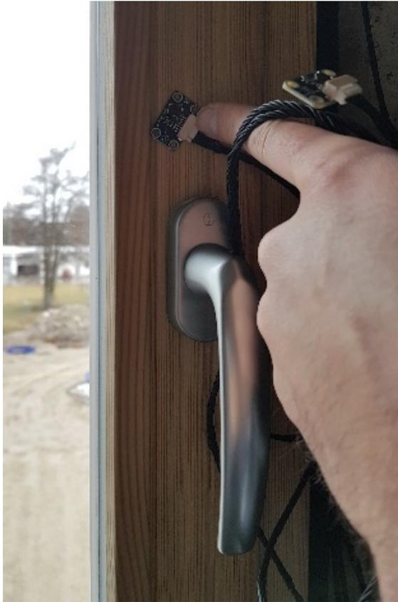
Abbildung 89: Planung der Anbringung der Fensterkontakte am Holzrahmen; Foto@TUM
