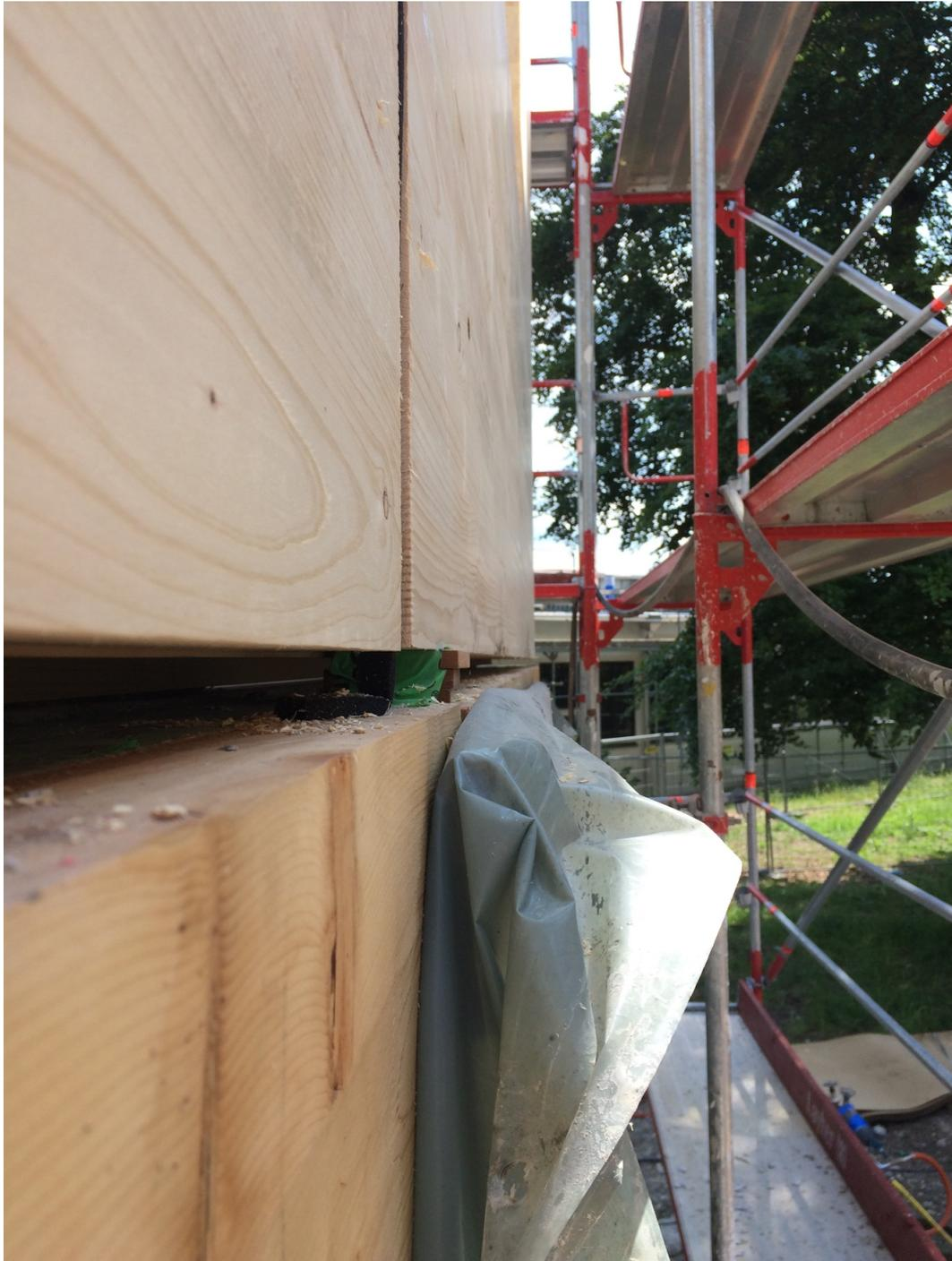
Abbildung 27: Durch den Druck des Betons und vermutlich auch die Flügelglättung hat sich die Wandkron des Erdgeschosses nach Außen bewegt.
