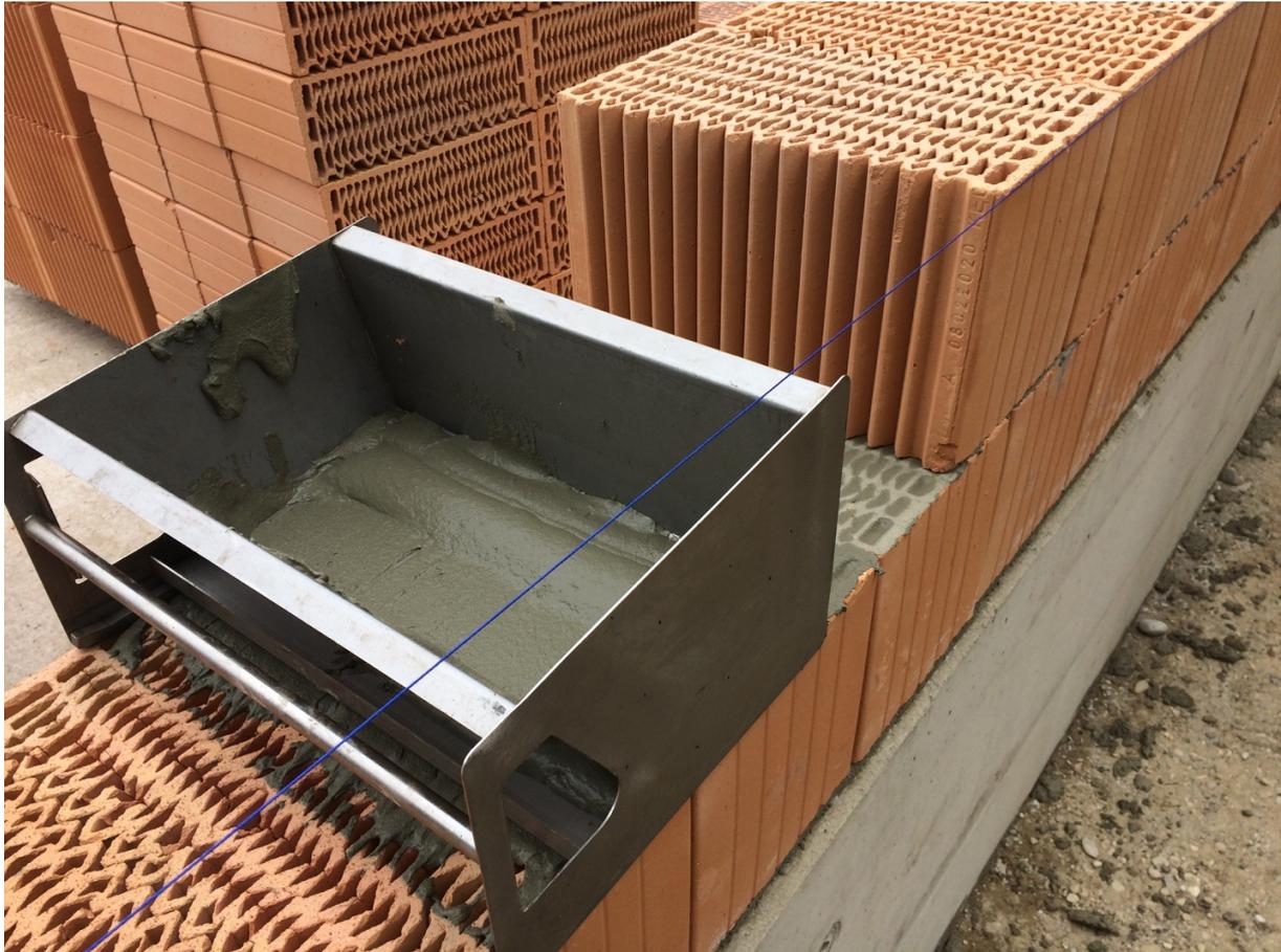
Abbildung 55: Dafür wird ein spezieller Mörtelschlitten verwendet.
