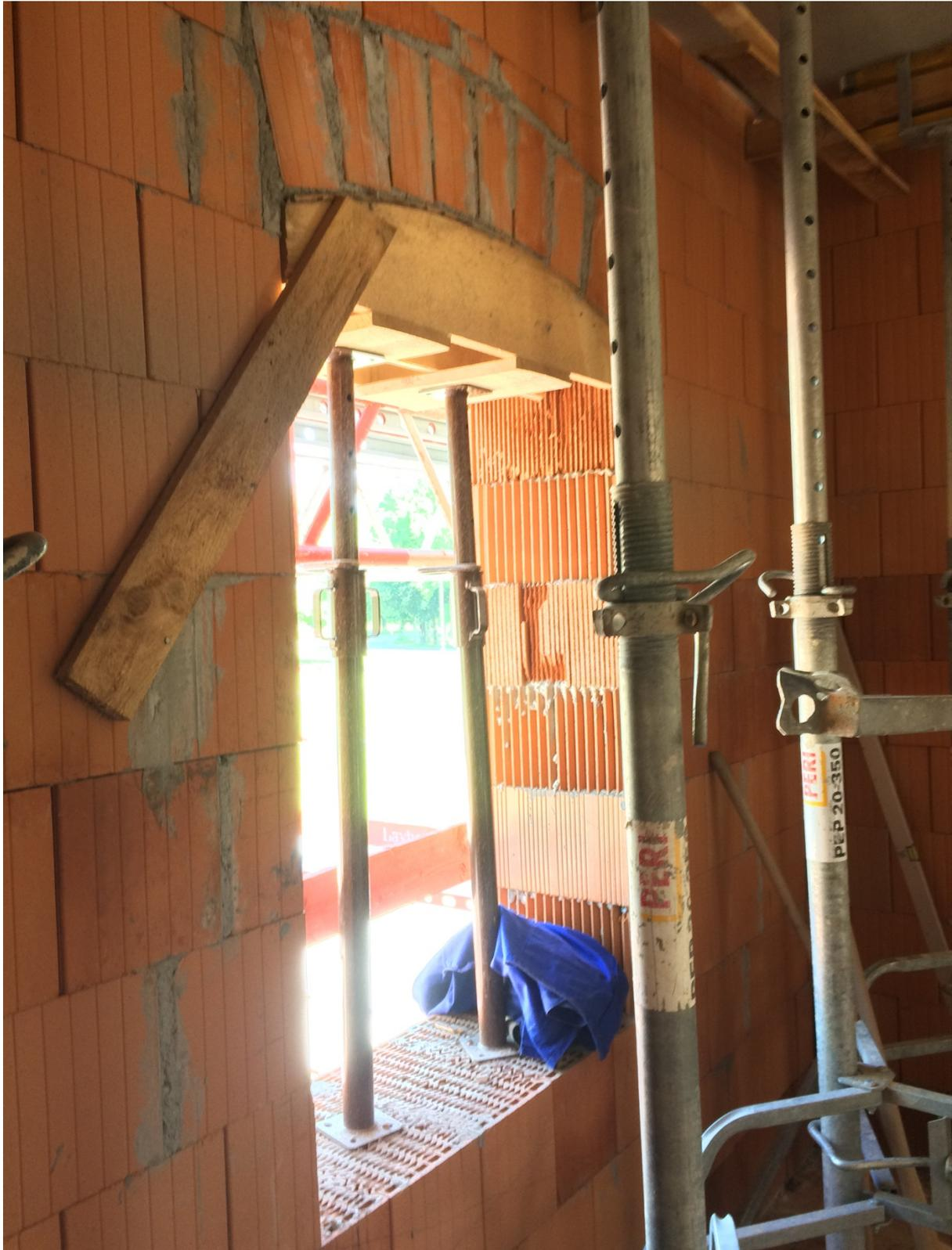
Abbildung 57: Der Sturz über den Fenstern wurde aus dem gleichen Stein wie die Außenwand als Segmentboden hergestellt.
