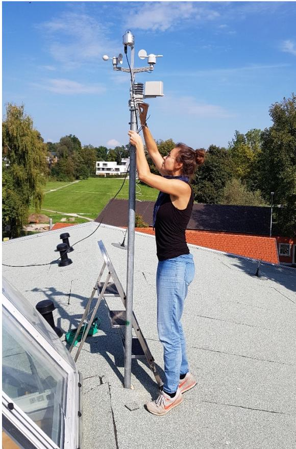
Abbildung 94: Installation der Wetterstation auf dem Dach des Leichtbetonhauses; Foto@TUM
