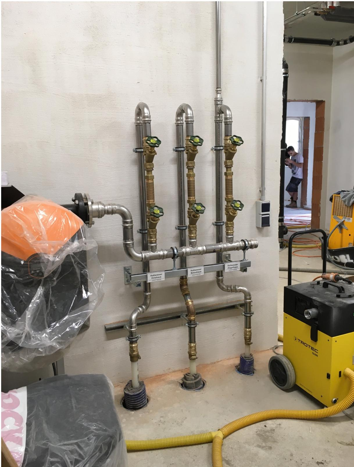
Abbildung 67: Verteilung des Frischwassers in die drei Gebäude.
