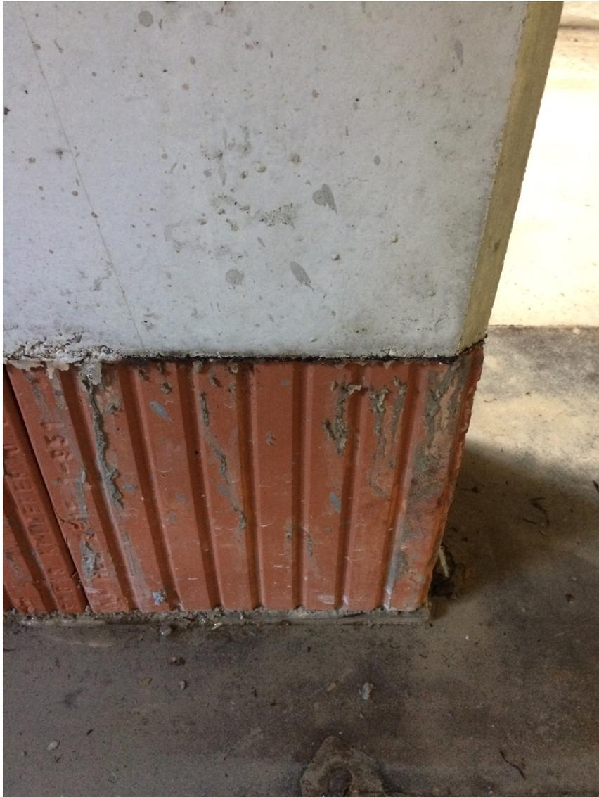
Abbildung 6: Fußpunkt der Innenwände.
