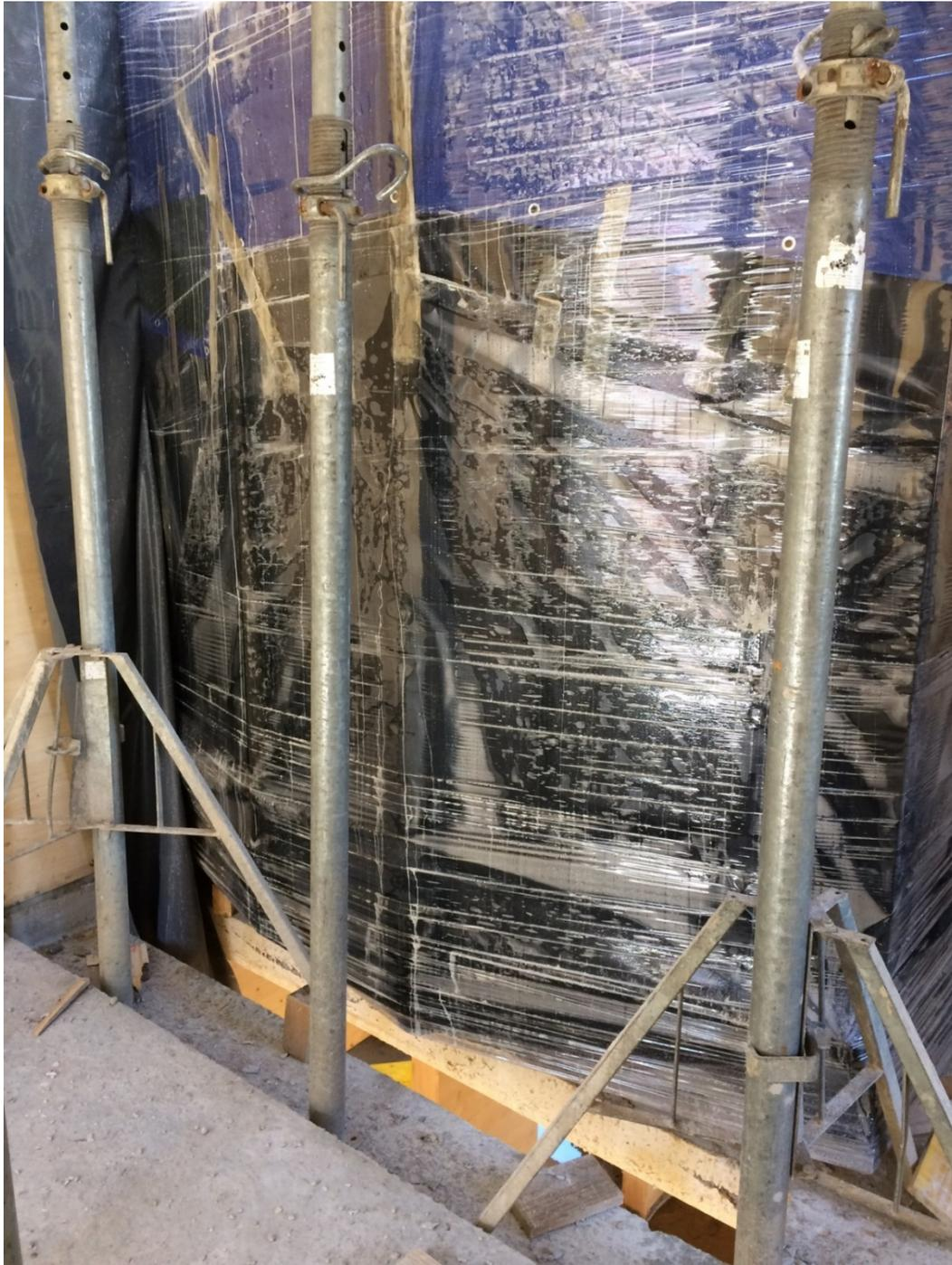
Abbildung 33: Die fertigen Badzellen sind in den entsprechenden Vertiefungen auf der Geschosdecke abgestellt und an den vertikalen Durchbrüchen positioniert.
