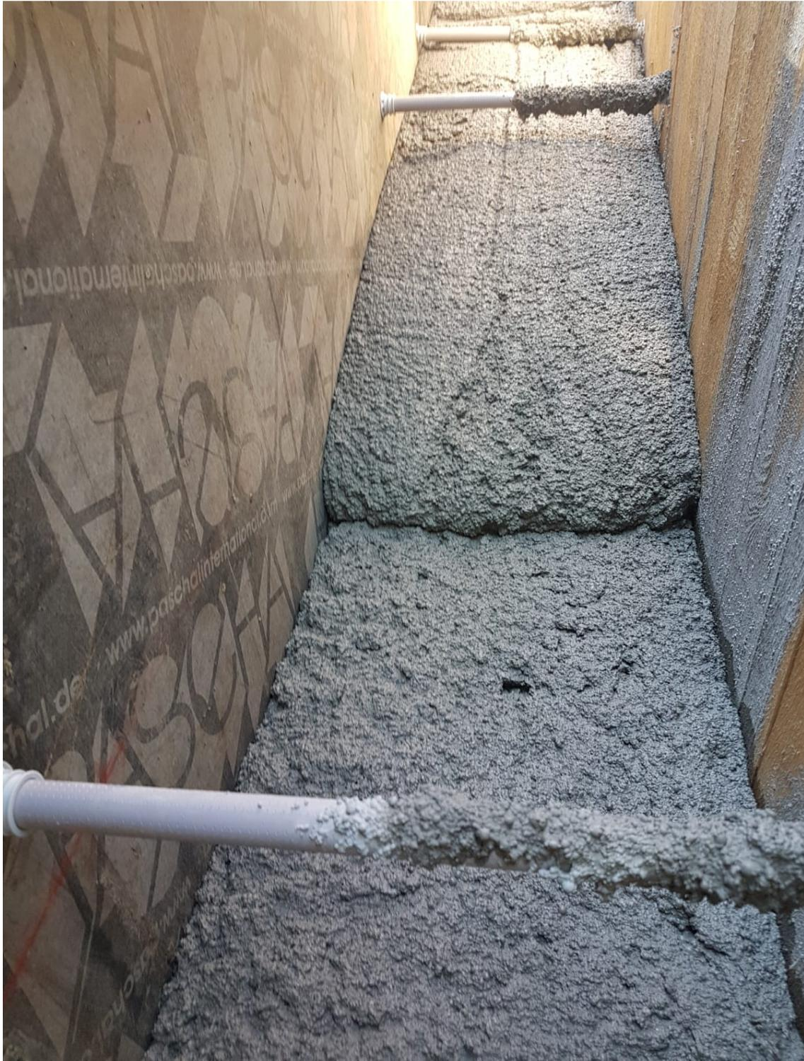
Abbildung 4: Blick von oben in die geschalzte Außenwand.
