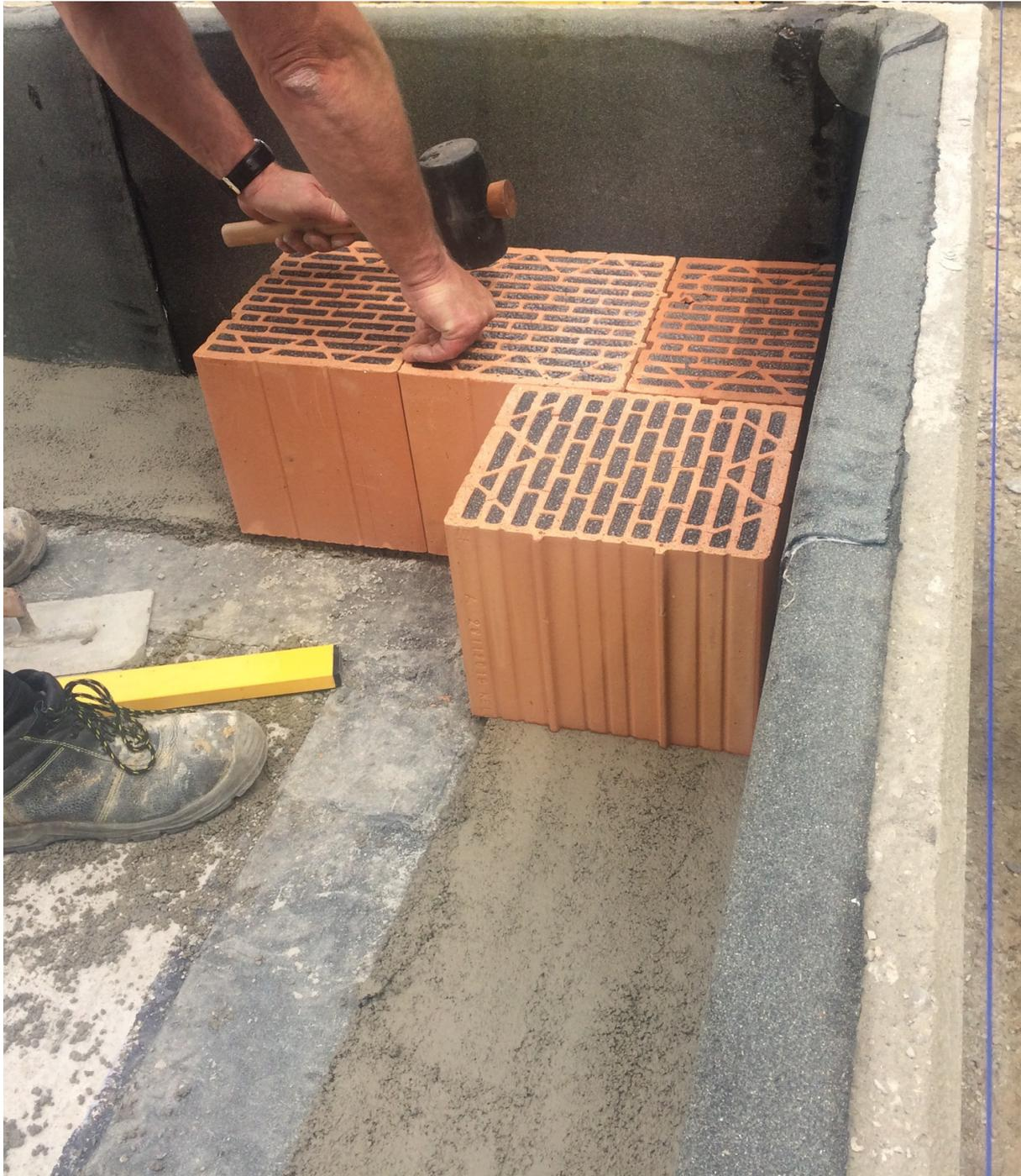
Abbildung 52: Der Kimmstein wird gesetzt.
