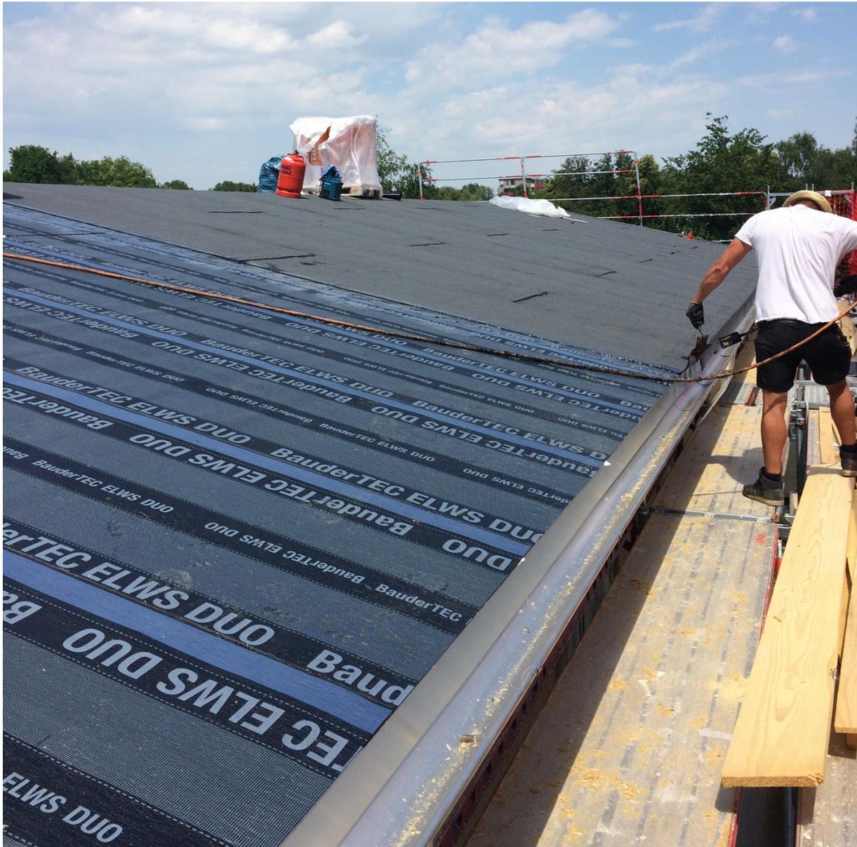
Abbildung 45: Das Dach wird eingedichtet.
