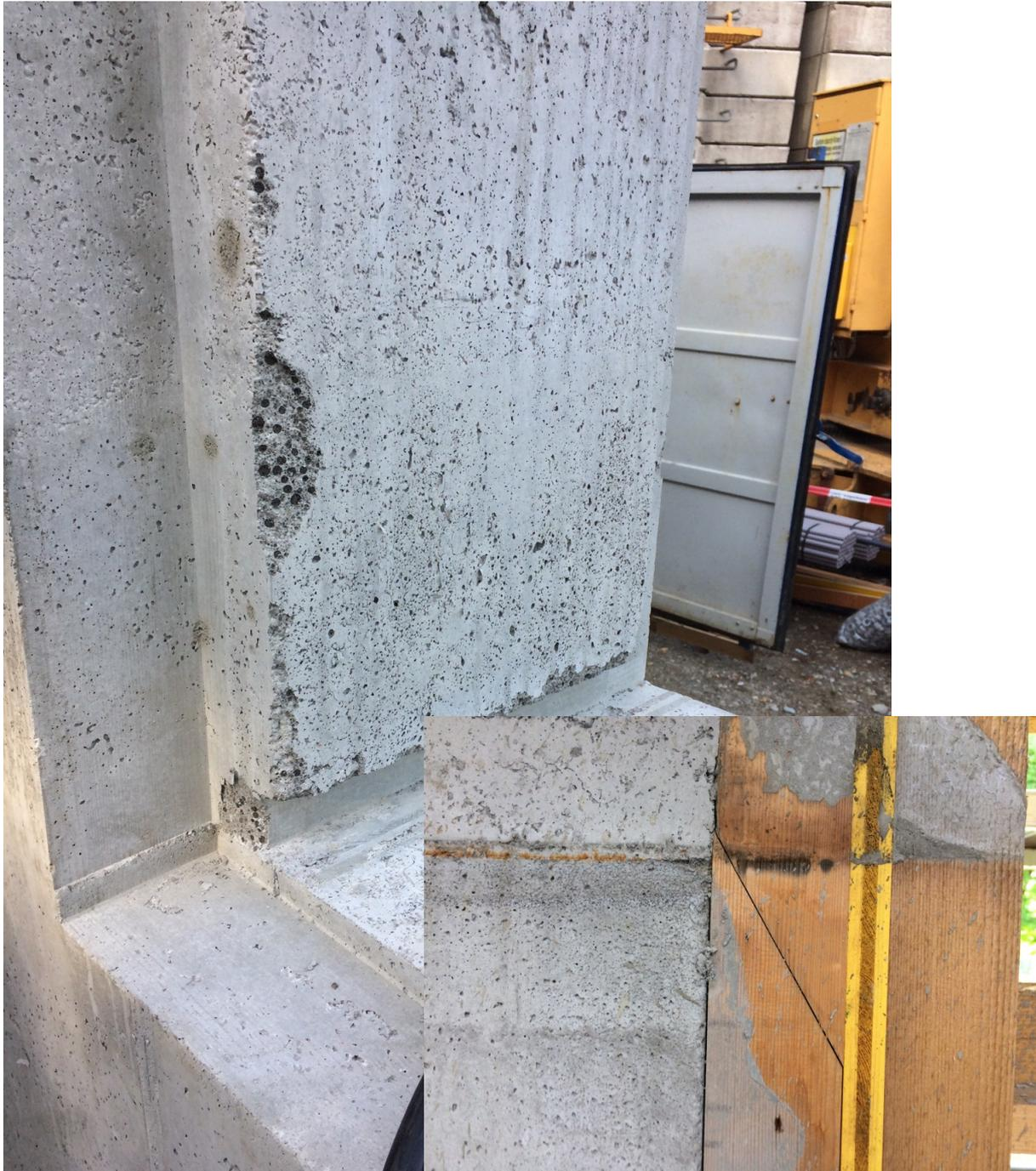
Abbildung 7: Durch die poröse Struktur des Infralichtbetons ist es beim Ausschalen zu Abplatzungen gekommen.
