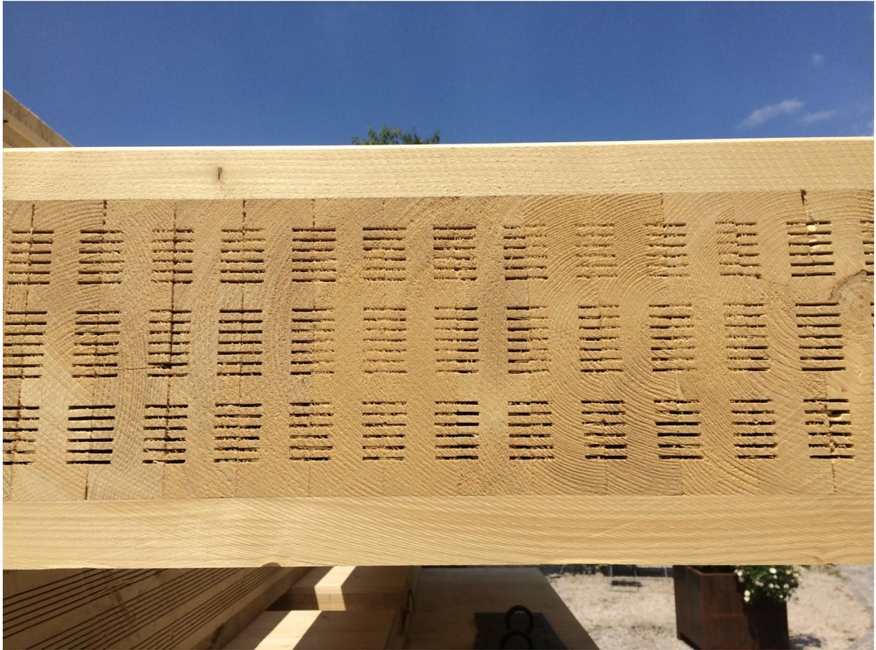
Abbildung 20: Schnittansicht der Außenwand des Holzhauses.
