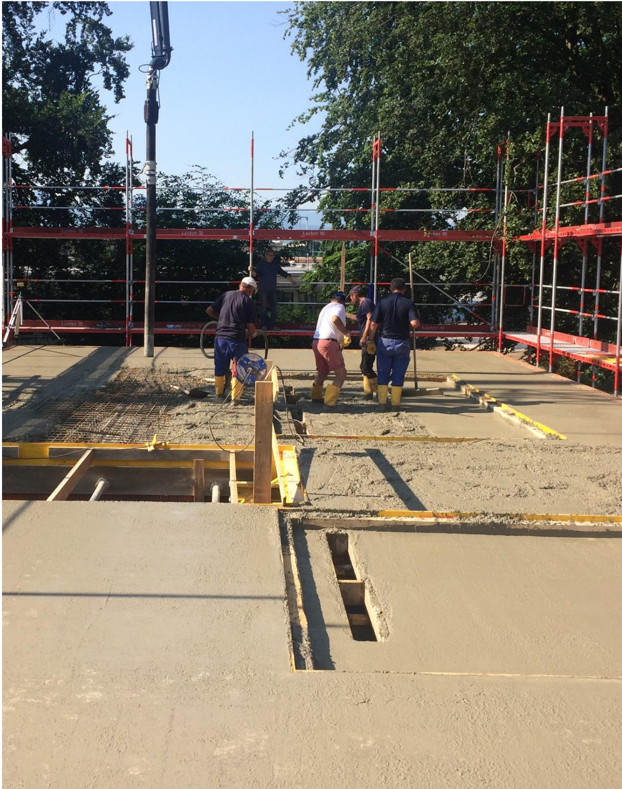
Abbildung 56: Betonage der Decke.
