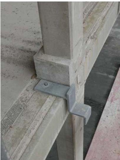
**Abb. 19** Bochum: Die Winkelkonstruktion nimmt die Fassadenelemente auf, leitet die Lasten in die Geschossdecken ein und gleicht Rohbau-Toleranzen aus. [© Friedrich May/BF Vario]
