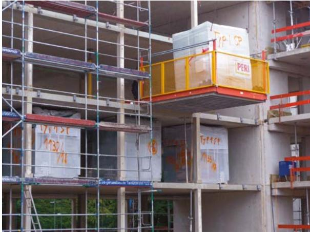
**Abb. 20** Bochum: Die Stahlleichtbau-Nasszellen werden vor Montage der Fassade in den Rohbau eingeschoben.
