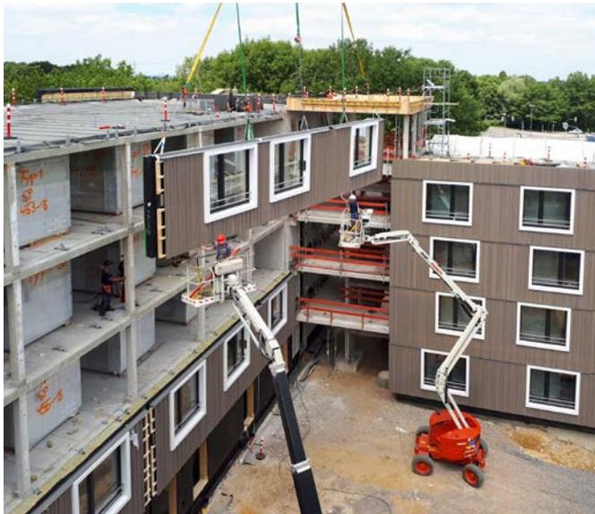
**Abb. 17** Bochum: Montage der geschosshohen Fassadenelemente [© ACMS Architekten]
