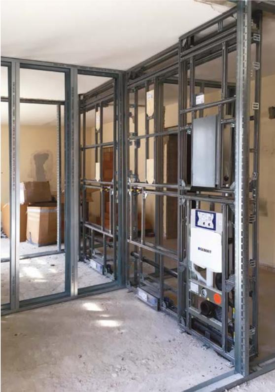
**Abb. 168** Vorgefertigte Installationswand mit WC-Spülkasten, Durchlauferhitzer und Duschablauf [© TUD, Fachgebiet Entwerfen und Baukonstruktion]
