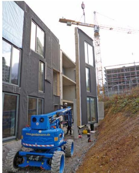
**Abb. 18** Wuppertal-Griffenberg: Montage der haushohen Fassadenelemente [© ACMS Architekten]
