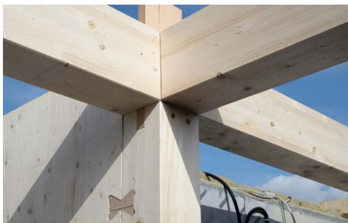
**Abb. 146** Kennzeichen des Projektes sind reine Holz-Holz-Verbindungen, die eine schnelle Montage erlauben. [© DGJ Architekten]
