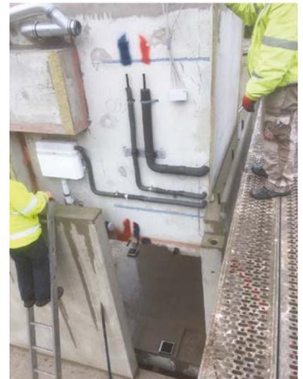
**Abb. 22** Hamburg-Harburg: Beim Platzieren der Beton-Fertignasszellen zwischen den Stahlbetonwänden ist hohe Sorgfalt gefragt. [© Andreas Hartmann/TU Berlin]
