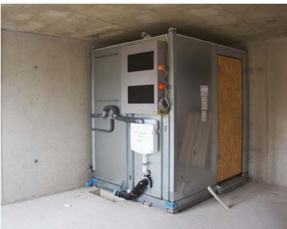
**Abb. 175** Vorgefertigte Nasszelle mit Installationselementen [© Friedrich May/BFVario]
