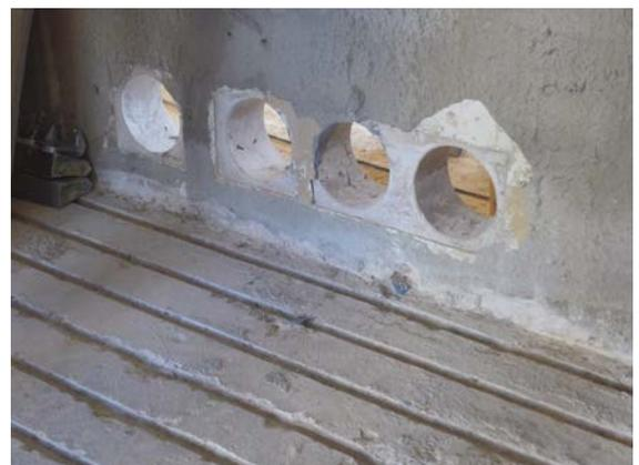
**Abb. 133** Aufwendige Nacharbeiten am Rohbau: Kernbohrungen zur Leitungsführung und Ergänzung der oberen Bewehrungslage im Deckenbereich
