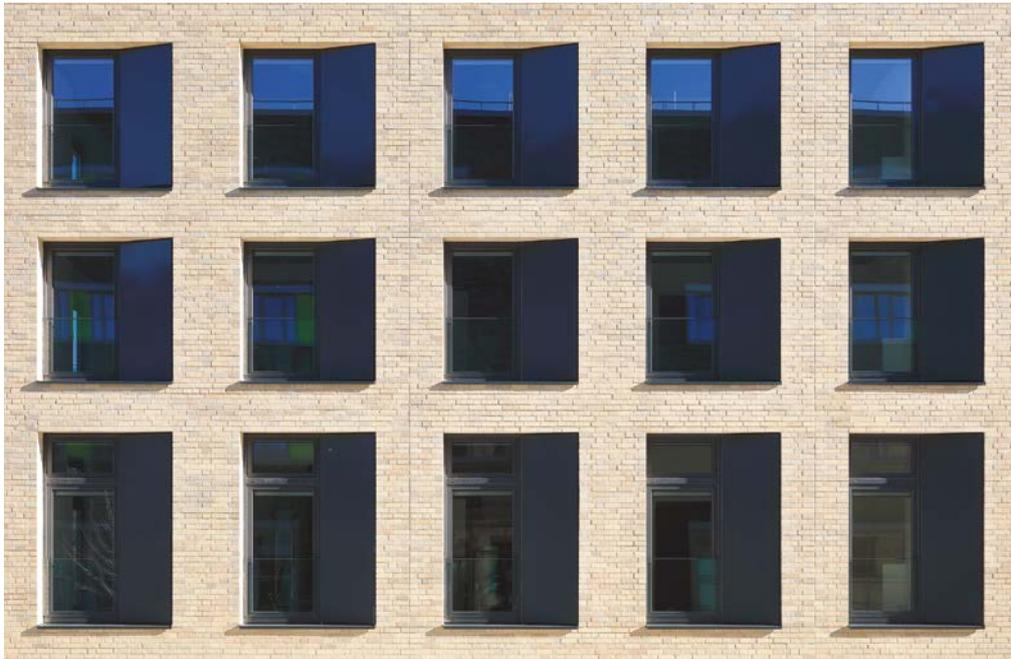
**Abb. 151** Fassadenausschnitt: Gut zu erkennen sind die gestalterisch eingesetzte Absturzsicherung aus Glas sowie eine Blechverkleidung neben dem Fenster, hinter der sich die dezentrale Luftansaugung für jeden Raum befindet. [© Hans Jürgen Landes, Dortmund]
