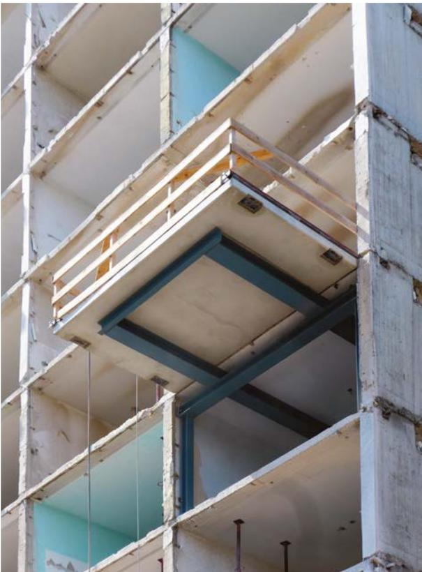
**Abb. 131** Auf Rohbau rückgebaute Strukturen mit Wohnraumerweiterungsplatte. Die Stahlkonstruktion wurde nur temporär für den Einbau des Probemoduls benötigt, später werden die Wohnraumerweiterungen separat gegründet.
