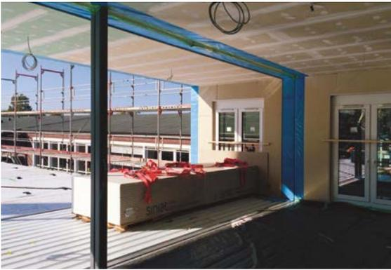
**Abb. 29** Hamburg-Steilshoop: Die Modulbauweise verkürzte nicht nur die Bauzeit, sondern half auch Bauwerkskosten einzusparen. Die Raumzellen wurden komplett mit Fenstern, Trockenbau und vorinstallierter Elektrik geliefert.
