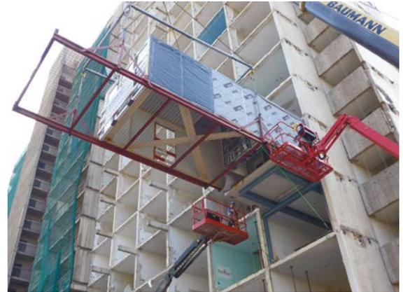
**Abb. 132** Einschub des Probe-Raummoduls mittels einer Hilfskonstruktion aus Stahlträgern
