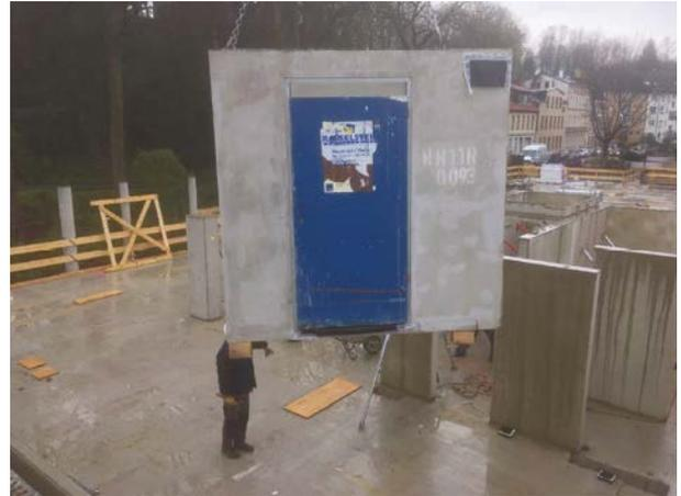
**Abb. 21** Hamburg-Harburg: Die Leichtbeton-Nasszellen werden geschossweise mit dem Kran platziert. [© Andreas Hartmann/TU Berlin]
