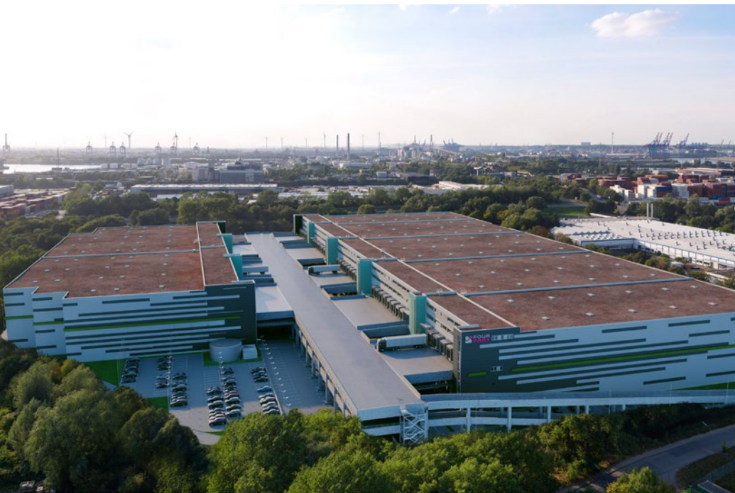
Abb. 128: Zweistöckige Logistikhallen, Hamburg-Wilhelmsburg
