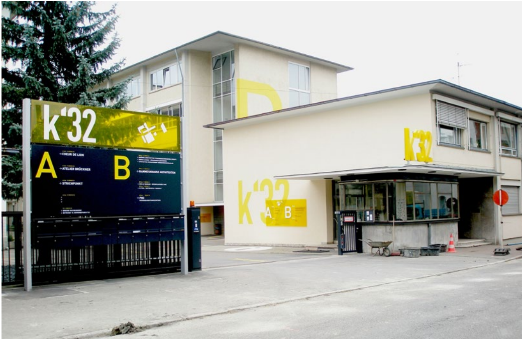
Abb. 122: Gewerbepark K32, Stuttgart-Bad Cannstatt
