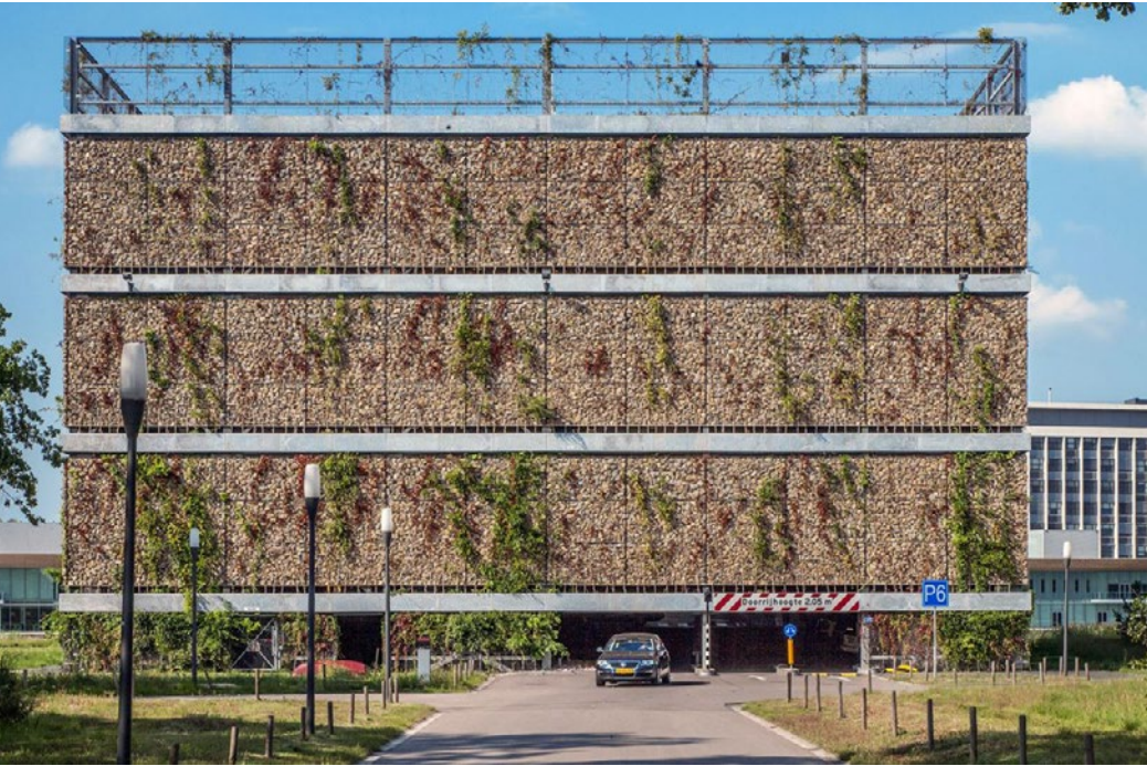
Abb. 134: vertikal begrünte Parkierungsanlage HTC
