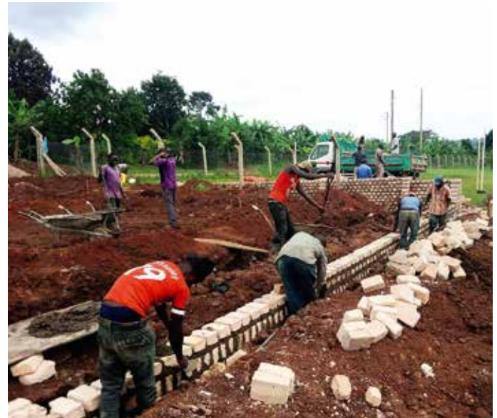
Bau der Fundamente für ein neues Laborgebäude.
