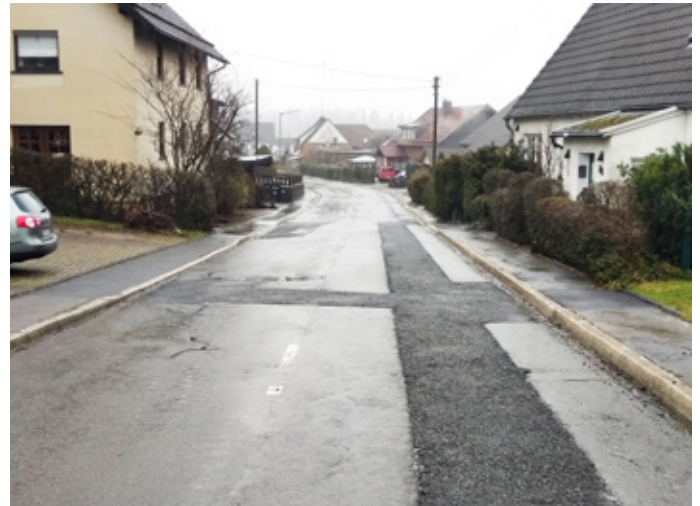
Die K 43 wird ab der 25. Kalenderwoche durch umfangreiche Bauarbeiten instand gesetzt. Foto: C. Rossenbach
