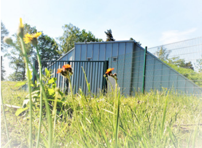
Ein neuer Ringschluss zur Einspeisestelle des Aggerverbandes in Oberzielenbach und dem Hochbehälter in Hahn soll die Wasserversorgung im Hauptort Morsbach gewährleisten. Foto: A. Weber
