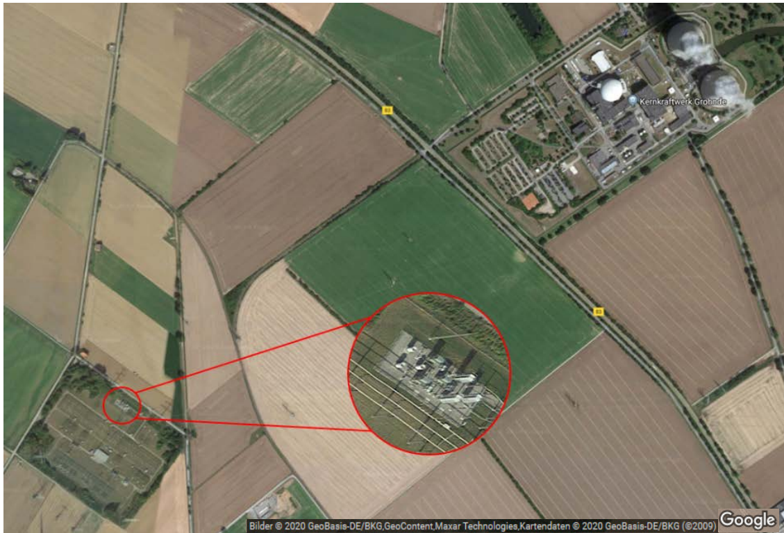
Abb. 2.8 Statische Blindleistungskompensatoren in der 380 kV-Schaltanlage des Kernkraftwerks Grohnde
