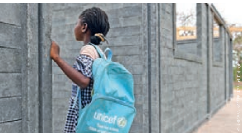
Elfenbeinküste: Im Dorf Sakassou entstehen aus recyceltem Plastik neue Klassenräume.
