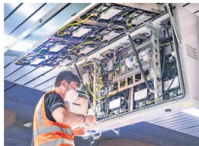
Die Techniker arbeiten unter Hochdruck an der Installation
