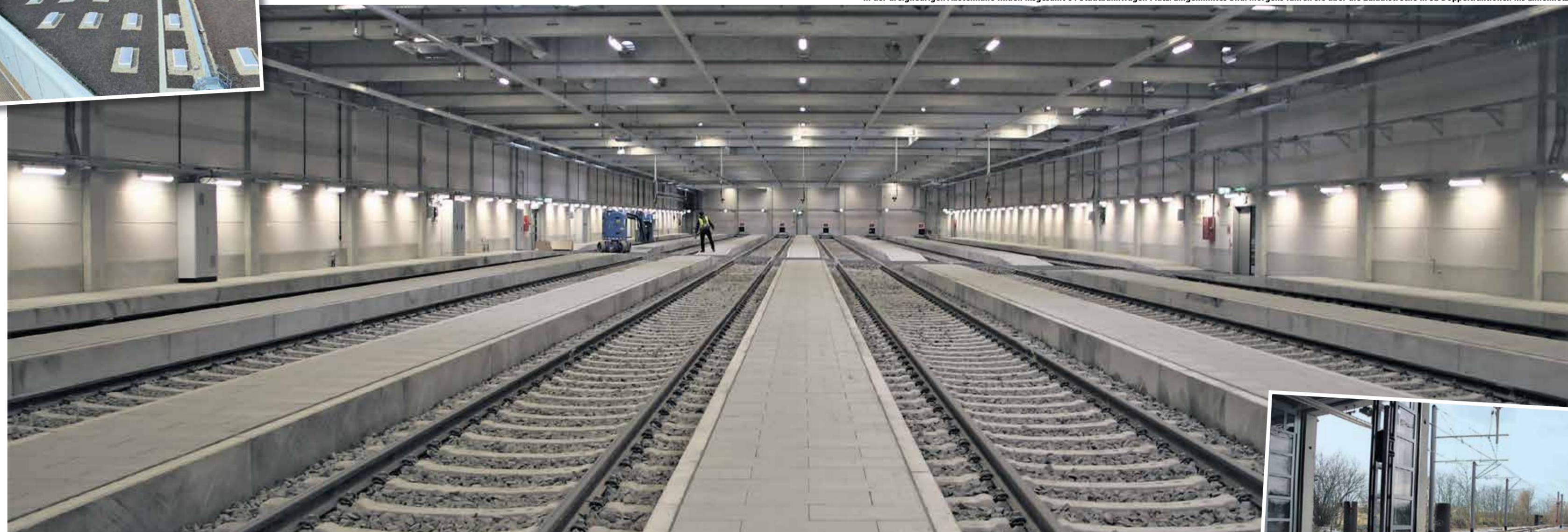
In der dreigliedrigen Abstellhalle finden insgesamt 64 Stadtbahnen Platz. Eingeklinktes Bild: Morgens fahren sie über die Zulaufstrecke in 32 Doppeltraktionen ins Liniennetz
