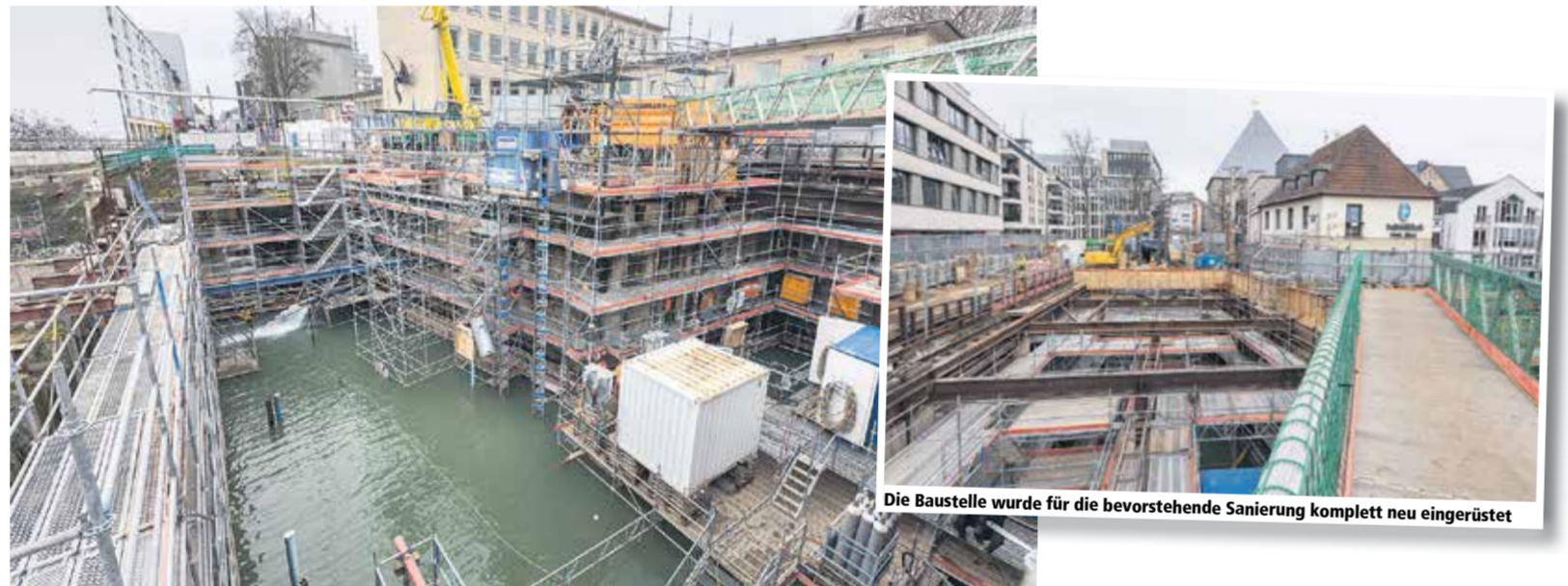
Aktuell steht das Grundwasser in der Baugrube, in der Taucherarbeiten stattfinden
