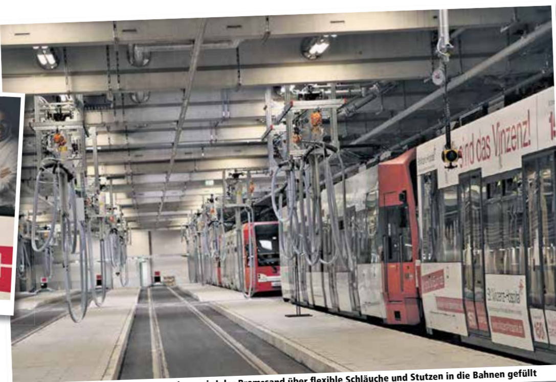
Mit der hochmodernen Besandungsanlage wird der Bremsand über flexible Schläuche und Stützen in die Bahnen gefüllt
