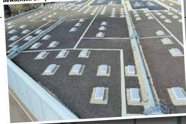
Das Dach schützt die Nachbarschaft vor Geräuschen. Es trägt zudem eine Photovoltaikanlage zur Erzeugung von Ökostrom, ist bewachsen und puffert Regenwasser
