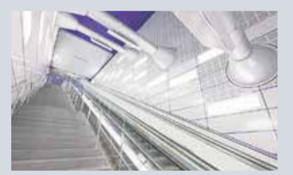
Spacig: die Treppenaufgänge in der unterirdischen Station
