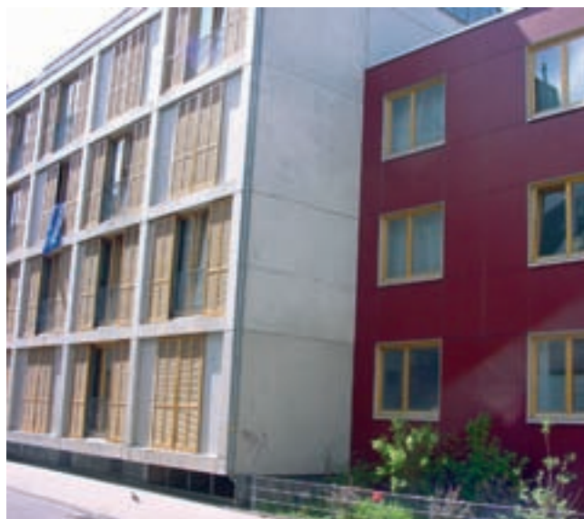
Neubauung des Grundstückes Körnerstraße 91
