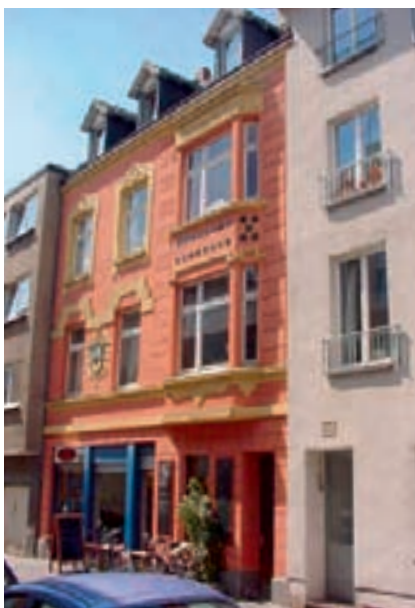
Fassade nach historischem Vorbild zurück gebaut
