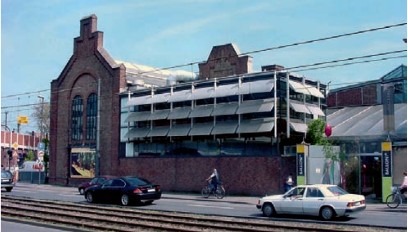
Teilansicht der Firma „Balloni“ am Ehrenfeldgürtel: Die ehemalige Kranfabrik wurde zu einem überregional bekannten Fachgeschäft für Dekorations- und Festartikel umgebaut. Alte Bausubstanz wurde dabei mit Neubauelementen in einer Stahl- Glaskonstruktion ergänzt.
