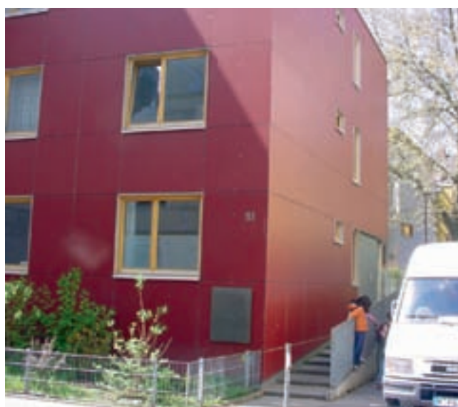
Im Blockinnenbereich hinter dem Haus Körnerstraße 91 wurde eine dreizügige Kindertagesstätte errichtet.
