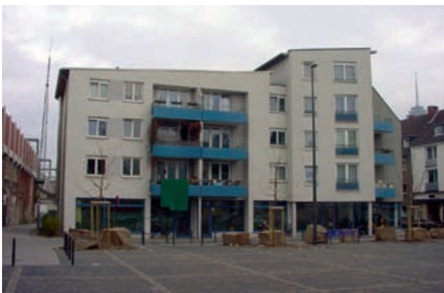
Die Neubebauung Glasstraße 7 – 9 wurde zum Bahnhofsvorplatz in Form eines Kopfbaus ausgeführt.
