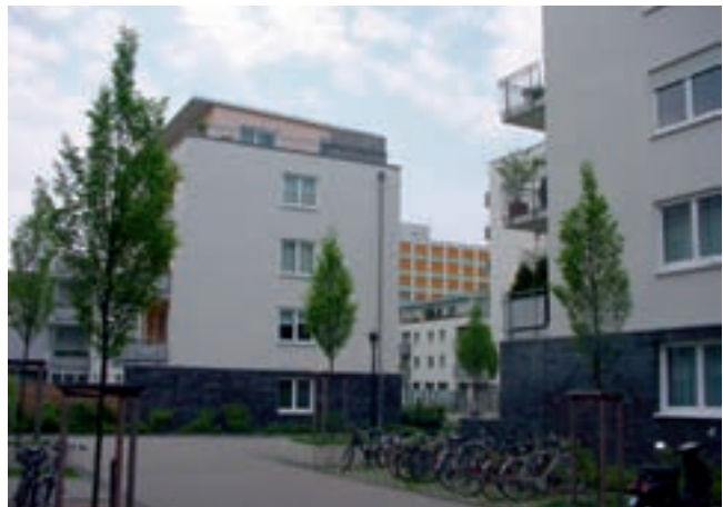
Im Blockinnenbereich der Piusstraße 22-24 befand sich früher die Firma Bleissem. Das Foto vermittelt einen Eindruck der dort entstandenen Neubebauung.
