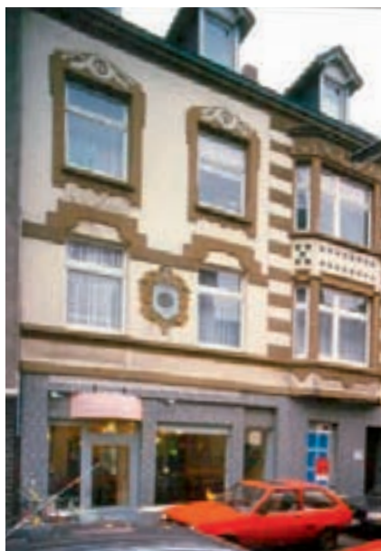
Körnerstraße 67, vorher im EG mit Fliesen verkleidet
