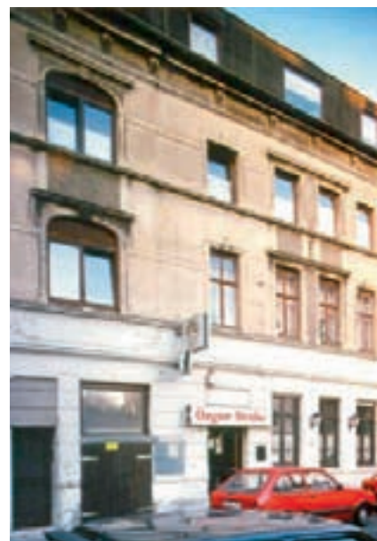
Fassade des denkmalgeschützten Gebäudes Stammstraße 37 vor der Instandsetzung
