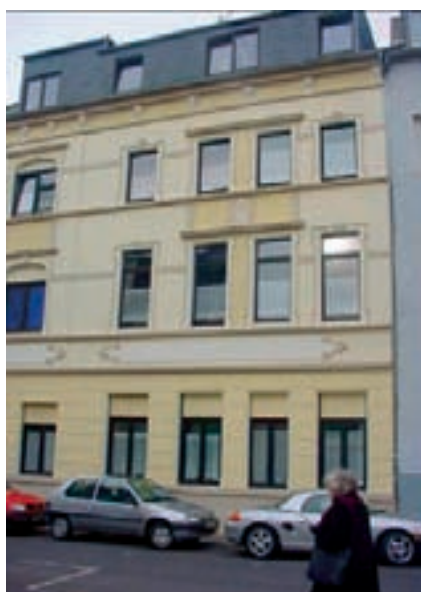
Im Rahmen der Fassadenerneuerung wurde die historische Gliederung wieder hergestellt. Störende Werbeanlagen wurden entfernt und die Dachaufbauten in Abstimmung mit dem Stadtkonservator neu verkleidet.
