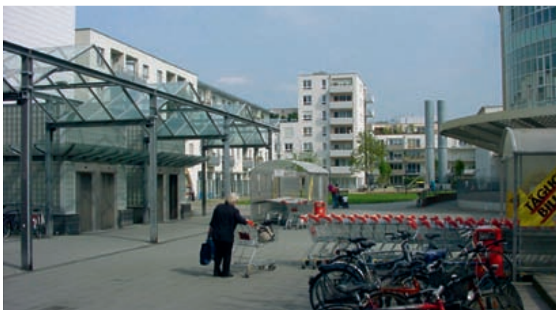
Innenbereich im Block 20: Vorhandene Bauten wurden geschickt mit neuen Elementen ergänzt. Im Hintergrund ist die Neubebauung des Bleissem-Geländes zu sehen
