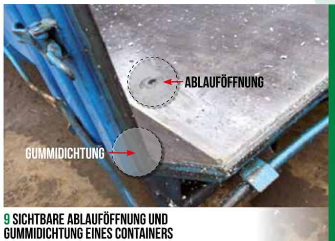
**9 SICHTBARE ABLAUFÖFFNUNG UND GUMMIDICHTUNG EINES CONTAINERS**
