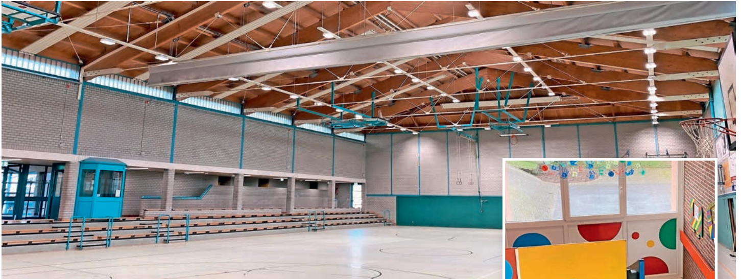
Abgeschlossen: Die energetische Sanierung der Hallen- und Sicherheitsbeleuchtung in der Walter-Rütt-Sporthalle (gr. Foto oben). Frische Farbe für eine frische Atmosphäre in der GGS Bardenberg.
